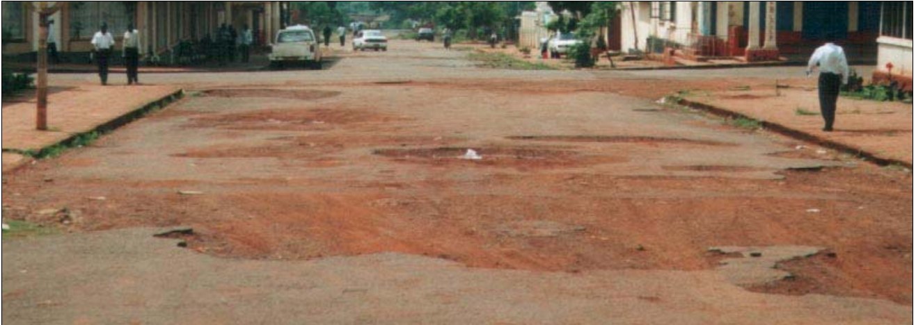
Foto 24: Beschädigte Straßendecke einer innerstädtischen Straße in Jinja/ Uganda
