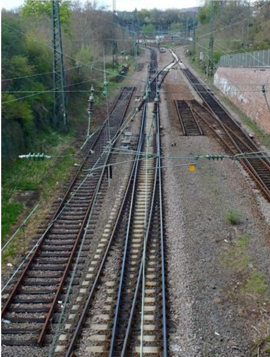
Abbildung 24: Sparmaßnahmen und Rückbau an der Ostseite von Saarbrücken Hbf
