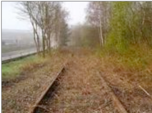
Abbildung 117: Blick auf die stillgelegte Bliestalbahn im Bereich Homburg-Beeden.
