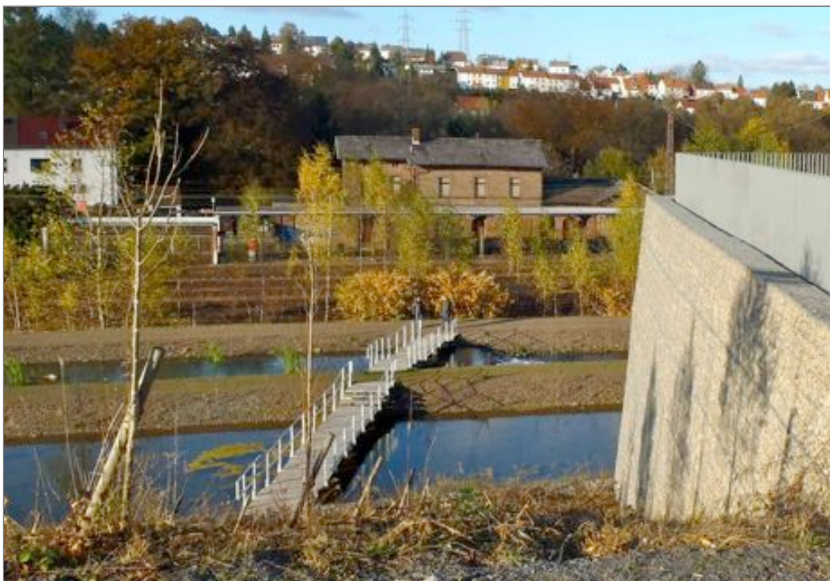
Abbildung 138: Blick auf den Haltepunkt von Landsweiler-Reden mit fehlender Fußgängeranbindung zum Freizeitpark
