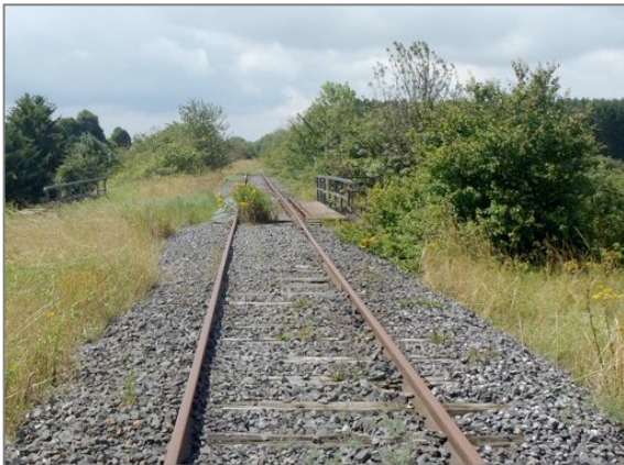
Abbildung 114: Blick auf die ungenutzte Strecke zwischen Fontoy und Ottange nördlich von Hayange und östlich der Zusammenführung mit dem Ast von Audun-le-Tiche über Aumetz.
