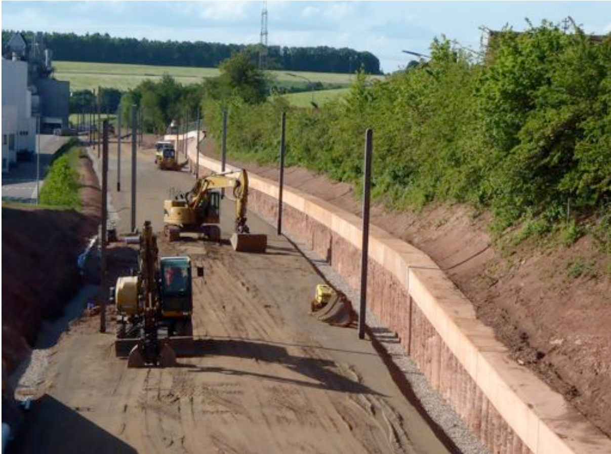
Abbildung 29: Bauarbeiten zur Saarbahnstrecke zwischen Heusweiler und Lebach
