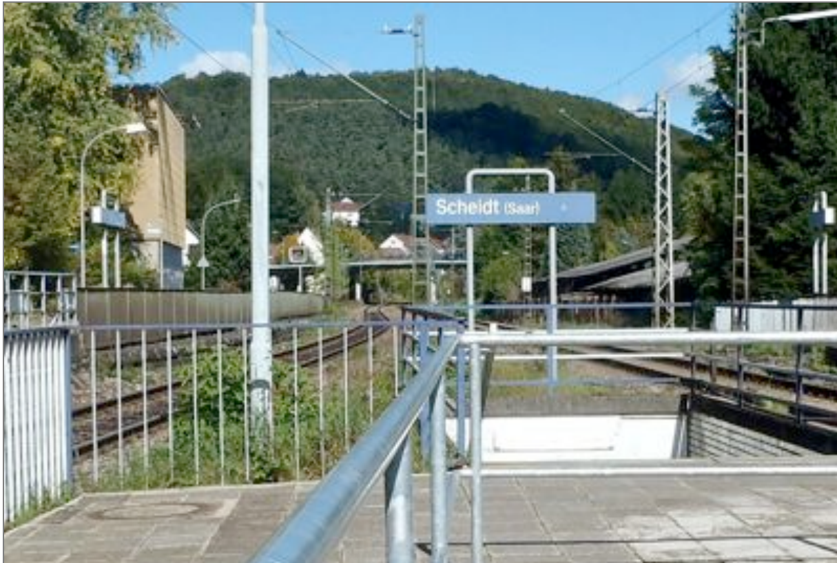
Abbildung 135: Blick vom Haltepunkt Scheidt auf die Straßenbrücke, die sich für eine verbesserte Verknüpfung von Eisenbahn und Ortslage anbietet
