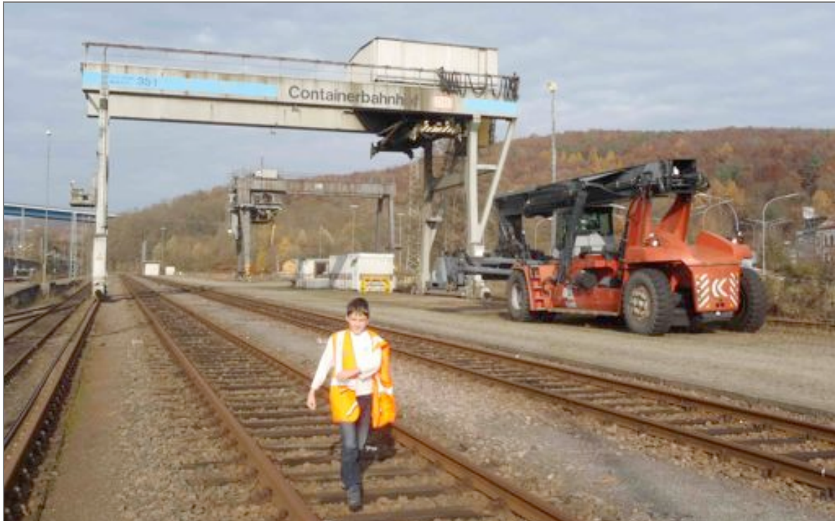
Abbildung 123: Verwaistes Containerterminal am Saarbrücker Güterbahnhof
