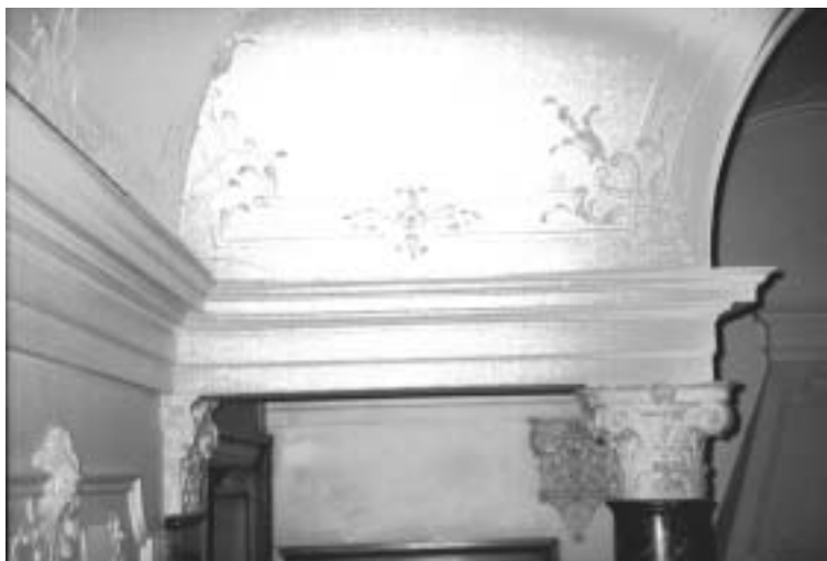
Abb.383 VILLA Wegmann, Halle Voute
