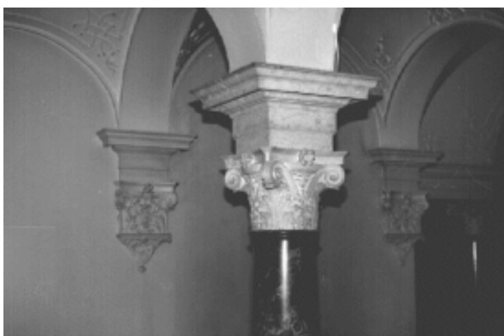
Abb.384 VILLA Wegmann, Halle Kapitell und Konsolen
