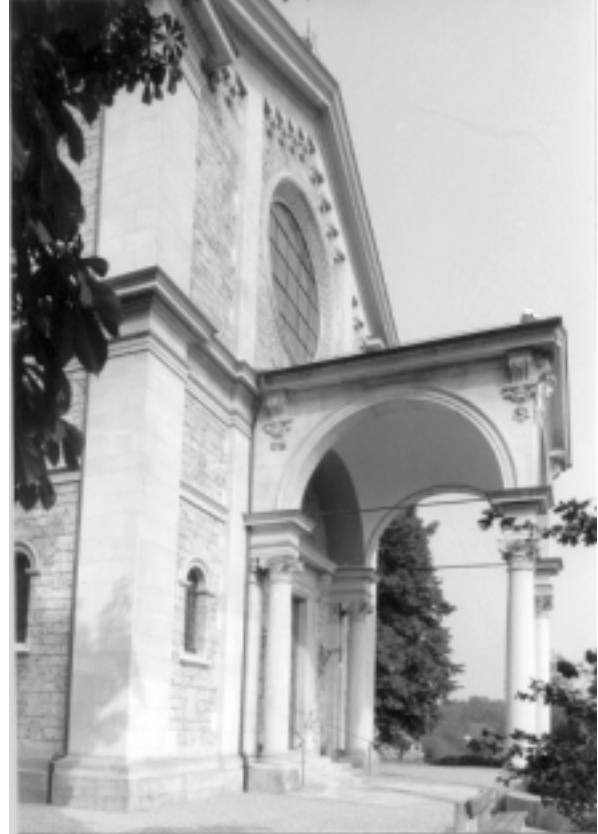
Abb.23 REFORMIERTE KIRCHE, Fassade
