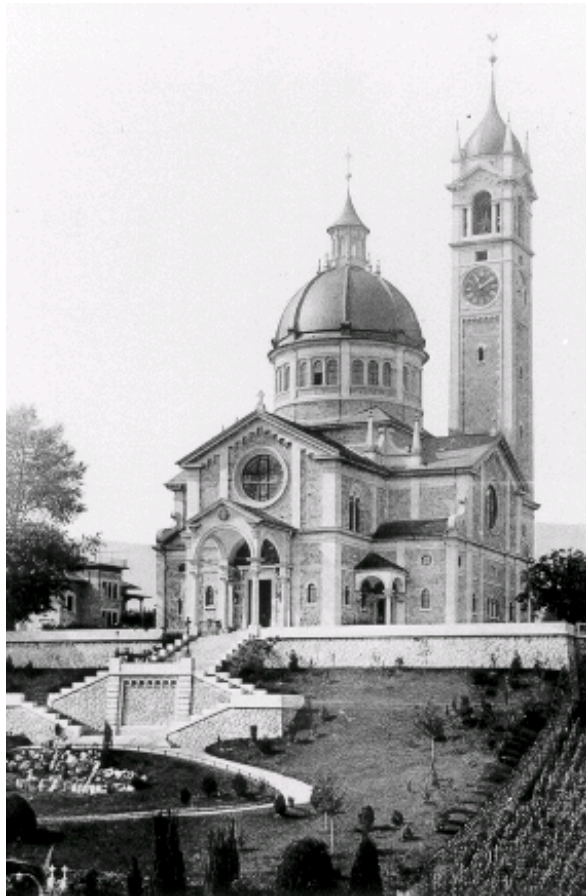
Abb.17 REFORMIERTE KIRCHE von Nordosten
