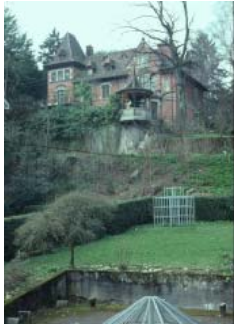
Abb.522 Villa Schönberg, UMBAU, Ostfassade
