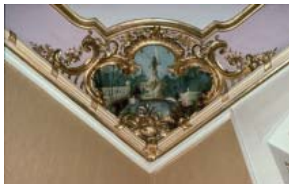
Abb.292 „SCHLOSS“ Holzhausen, Goldsalon Decke Nordostecke
