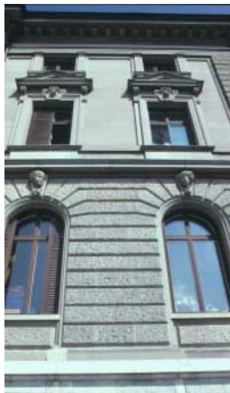
Abb.381 VILLA Wegmann, Gartenseite südlicher Teil
