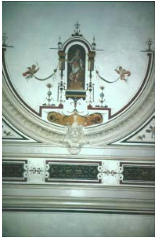
Abb.346 VILLA Bleuler, Halle im Obergeschoß Decke Detail
