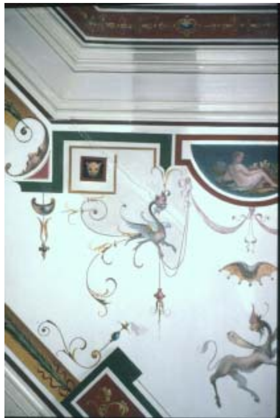
Abb.348 VILLA Bleuler, Halle im Obergeschoß Decke Detail
