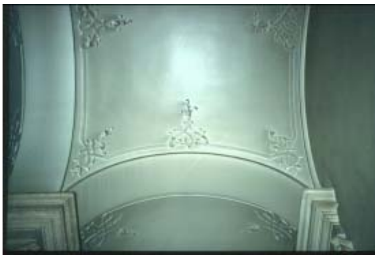
Abb.382 VILLA Wegmann, Halle Decke
