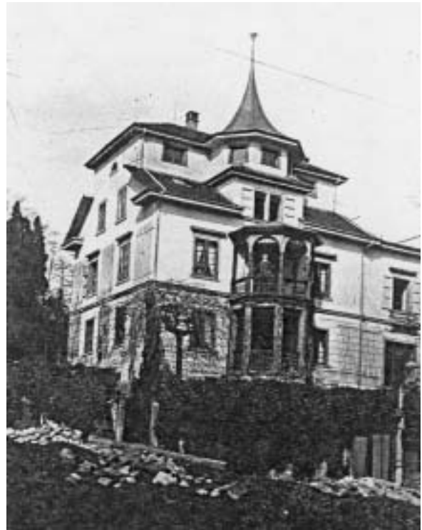
Abb.519 Wohnhaus Bluntschli, UMBAUTEN
