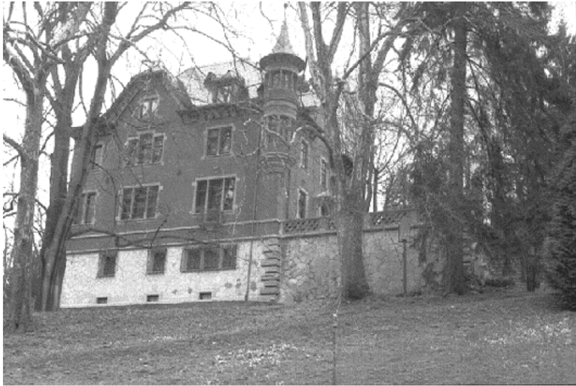
Abb.352 VILLA Rieter von Süden
