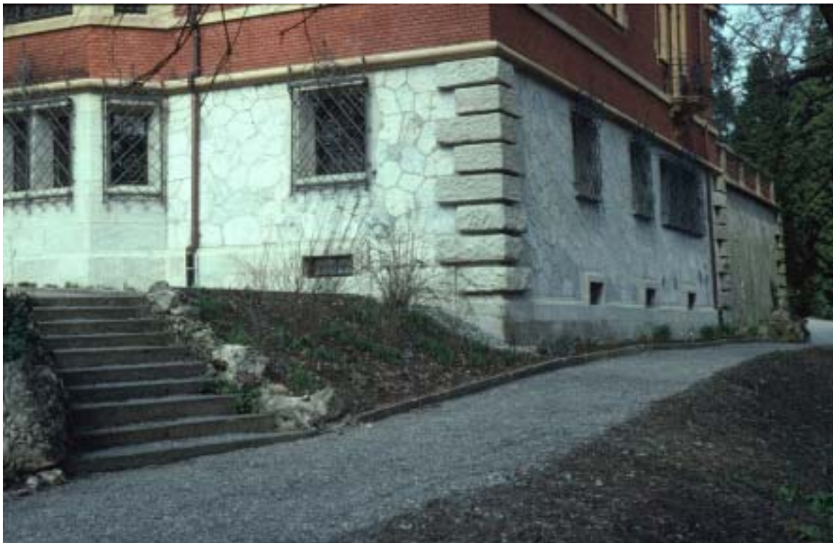
Abb.351 VILLA Rieter, Sockel von Südwesten
