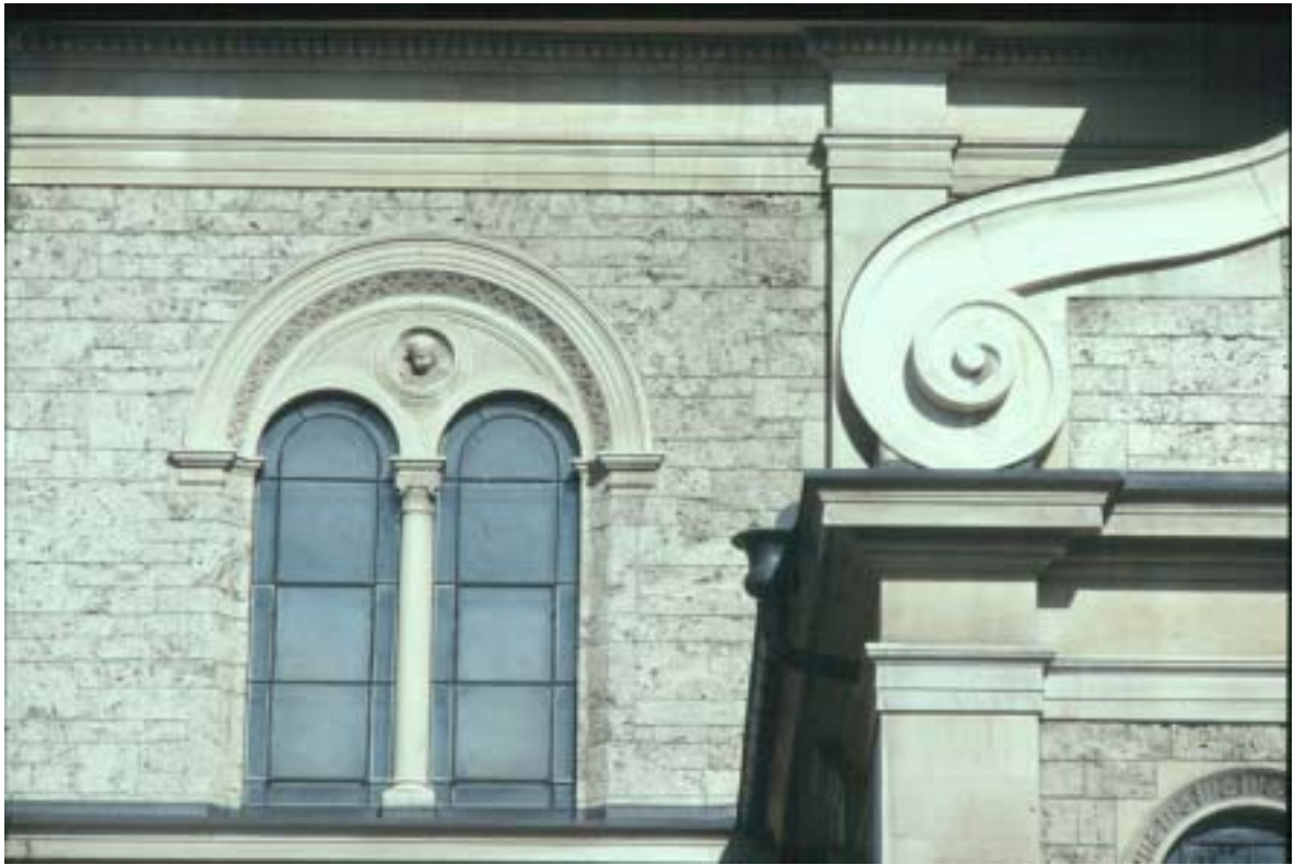
Abb.21 REFORMIERTE KIRCHE, Südseite Detail
