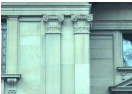
Abb.377 VILLA Wegmann, Ostfassade, Treppenhaus Detail
