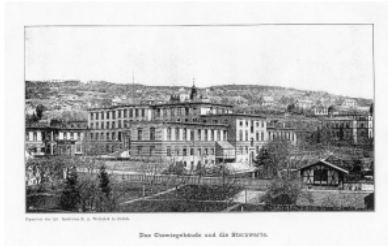
Abb.99 CHEMIEGEBÄUDE von Südwesten
