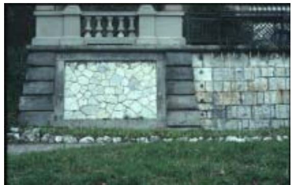
Abb.378 VILLA Wegmann, Stützmauer des linken Pavillons
