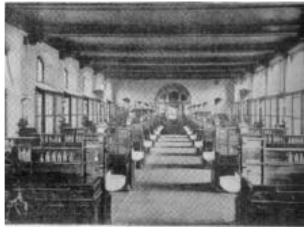
Abb.106 CHEMIEGEBÄUDE, großer Arbeitssaal
