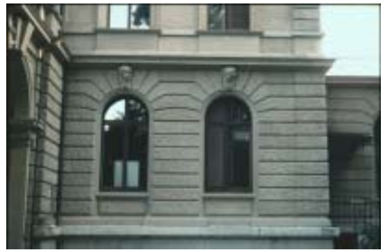
Abb.376 VILLA Wegmann, Ostfassade nördlicher Teil, Erdgeschoß
