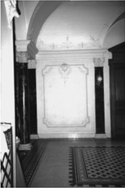
Abb.385 VILLA Wegmann, Halle
