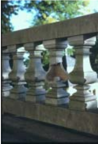
Abb.397 VILLA Wegmann, Terrassenbalustrade
