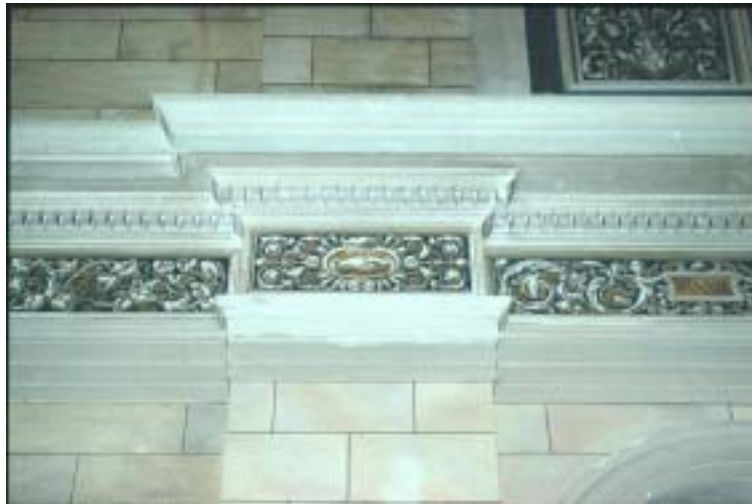
Abb.31 REFORMIERTE KIRCHE, Südempore, Westwand
