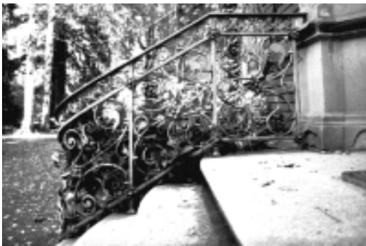
Abb.523 Villa Schönberg, UMBAU, Trepengeländer
