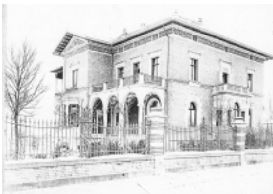
Abb.331 VILLA Bleuler von Südosten
