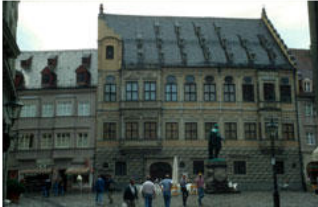
Foto 67: Böckensteinhaus in Augsburg (Aufnahme B. Bornemeier 1997)
