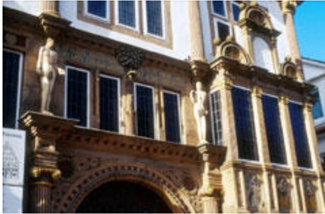
Foto 70: Fassadendetail des Hexenbürgermeisterhauses Lemgo (Aufnahme B. Bornemeier 2003)
