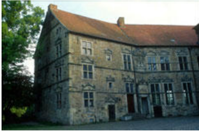
Foto 110: Amtshaus in Lüdinghausen (Aufnahme B. Bornemeier 1997)
