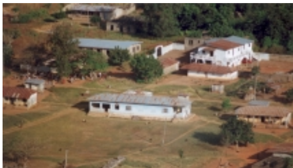
Abb. 23: Teilansicht von Ogidi: Im Hintergrund das weiß getünchte und ursprünglich für seine Mutter errichtete Wohnhaus, zweigeschossig und mit opulentem Eingangstor. Ogidi, 1998
