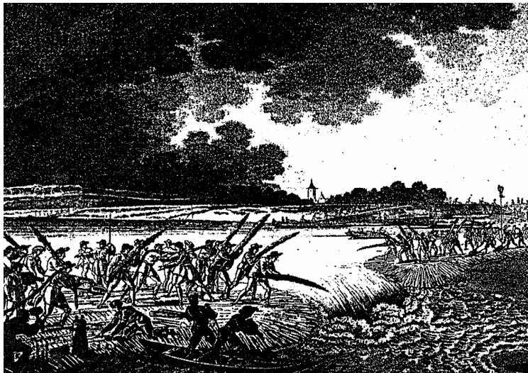
Abb. 1.2: Historischer Hochwasserschutz: Menschen bei der Herstellung einer sog. „Stromcoupierung“ (Durchstich). Quelle: EYTELWEIN (1800)
