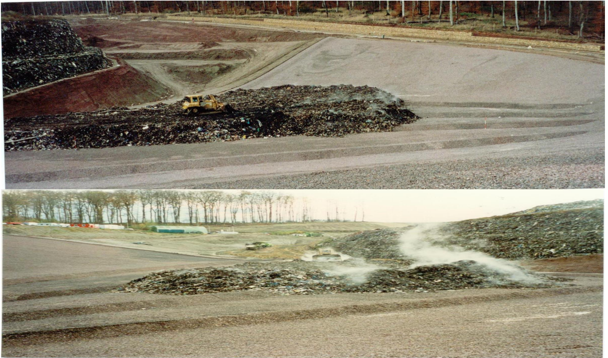
Bild 3: Umlagerung der Abfälle auf die basisabgedichtete Deponiefläche
