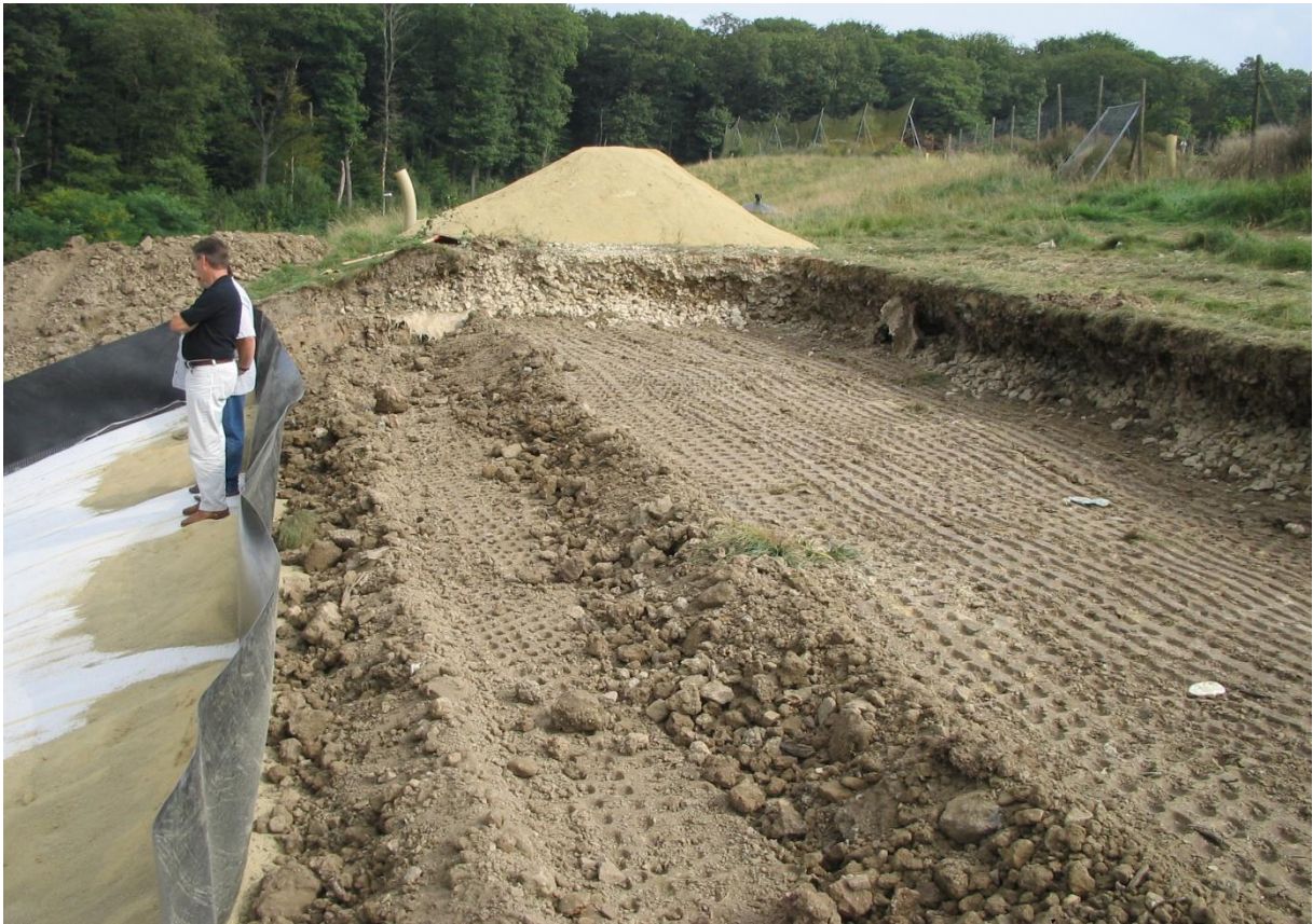
Bild 15: Einbindegraben oberhalb des Testfeldes
