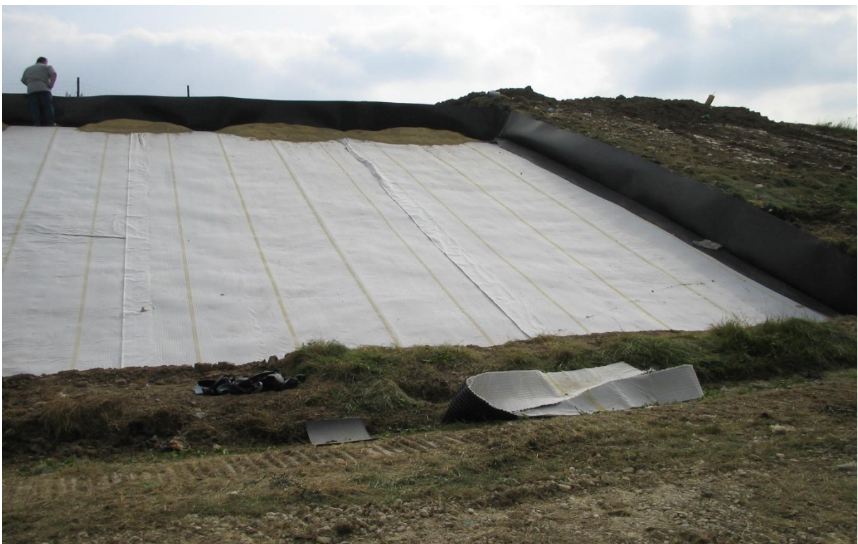
Bild 8: fertig verlegte obere Lage der Hohlrippendr nabahn
