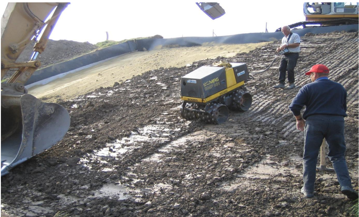
Bild 12: Verdichtung mit Grabenwalze
