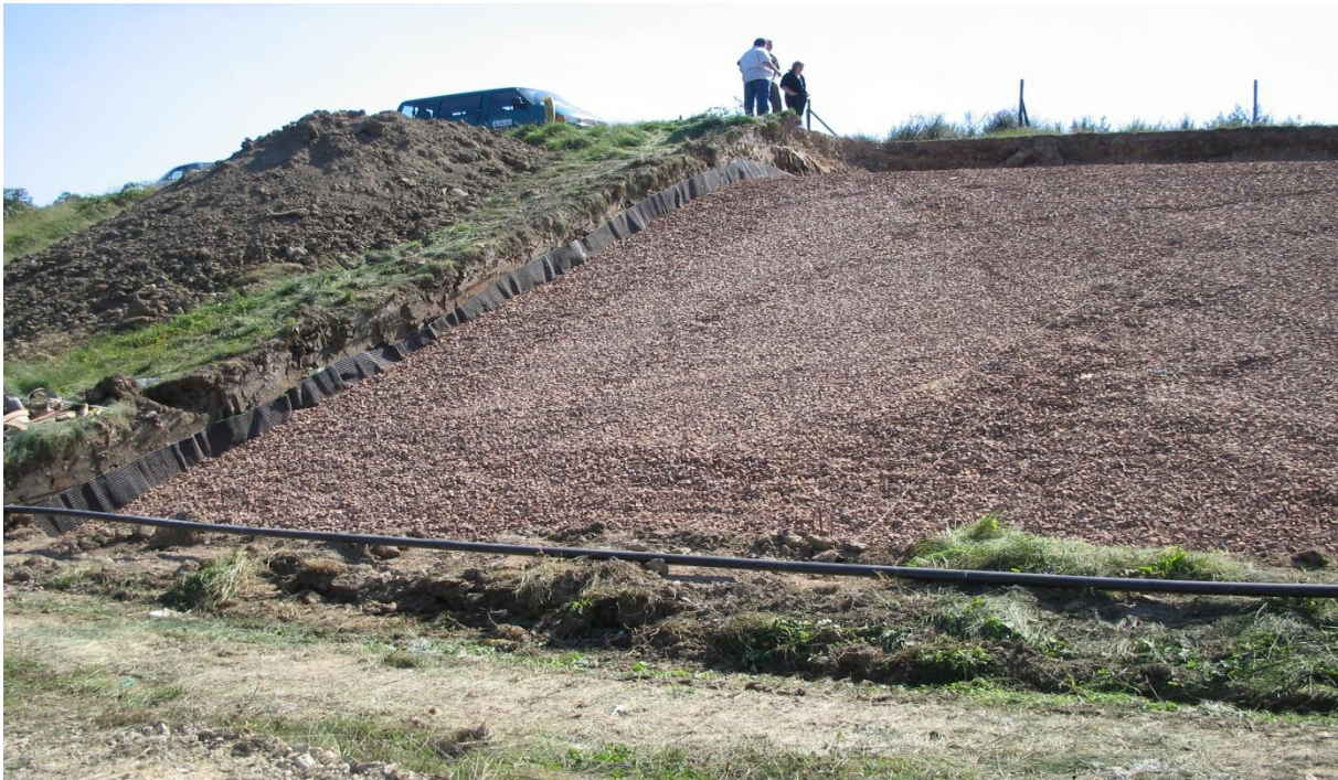
Bild 5: Schottererschicht
