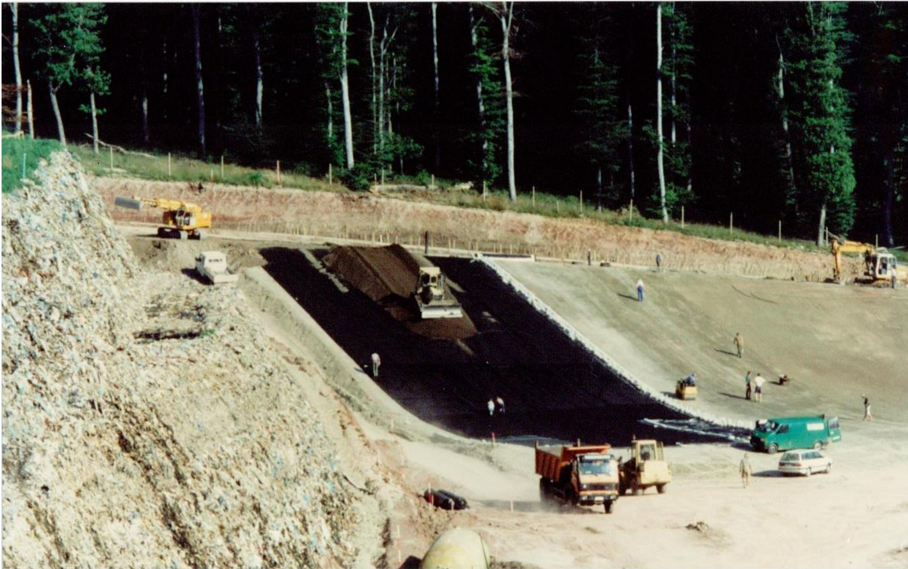
Bild 1: Bau der Basisabdichtung während der Sanierungsphase
