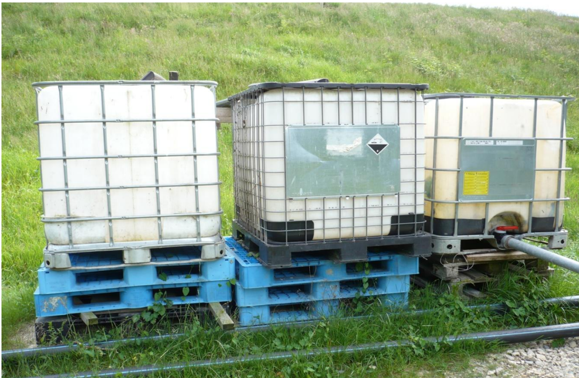
Bild 19: Messcontainer zur Erfassung der Abflüsse (links: Drainageabfluss, Mitte: Oberflächenabfluss, rechts: Gasdrainagewasser)
