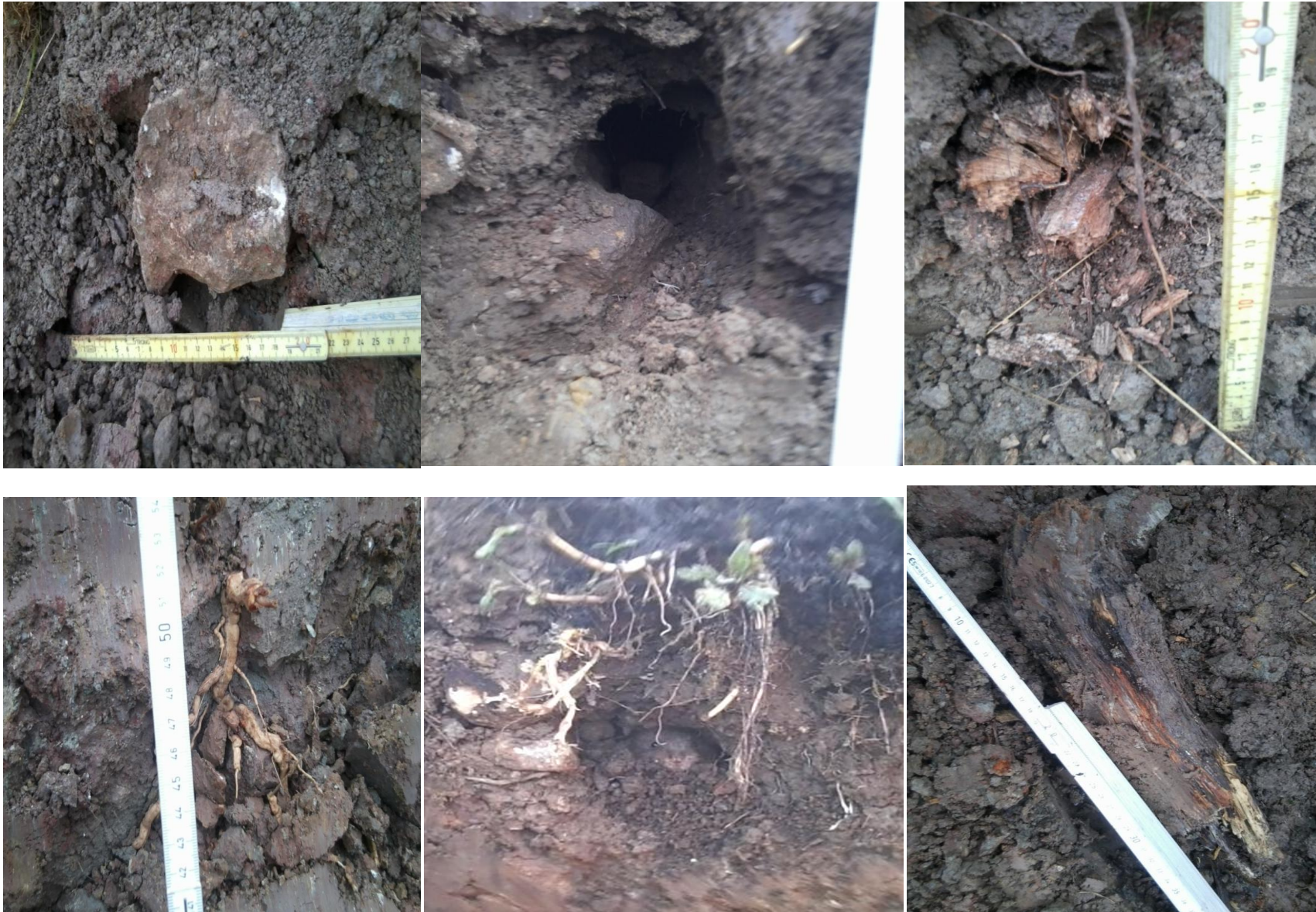
Bild 4: Steine, Holzreste, Mauselöcher und Wurzeln im Bodenmaterial der Abdeckung
