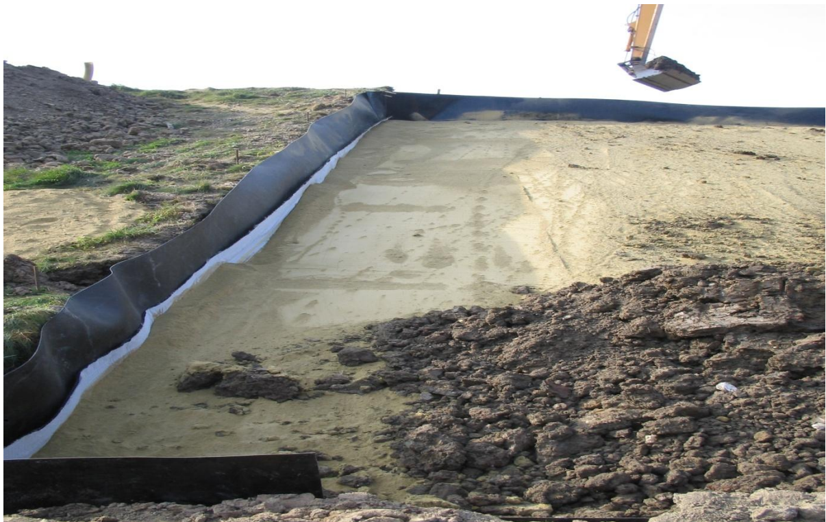
Bild 9: fertig eingebaute Kiesschicht
