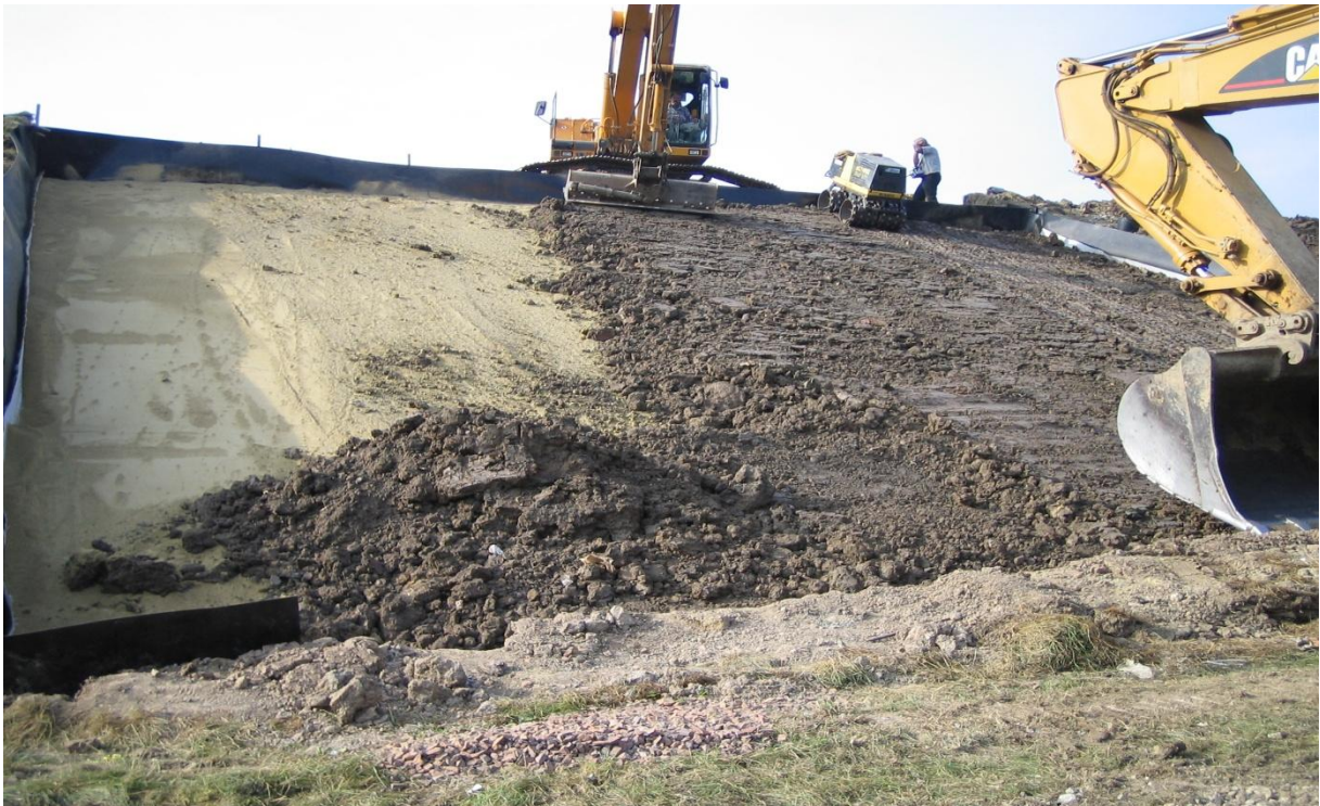
Bild 11: Einbau der Bodenabdeckung auf die Kiesschicht mittels Teleskoparmbaggern
