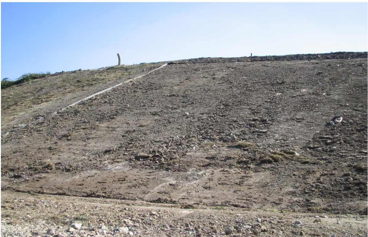
Bild 16: Testfeld nach Fertigstellung
