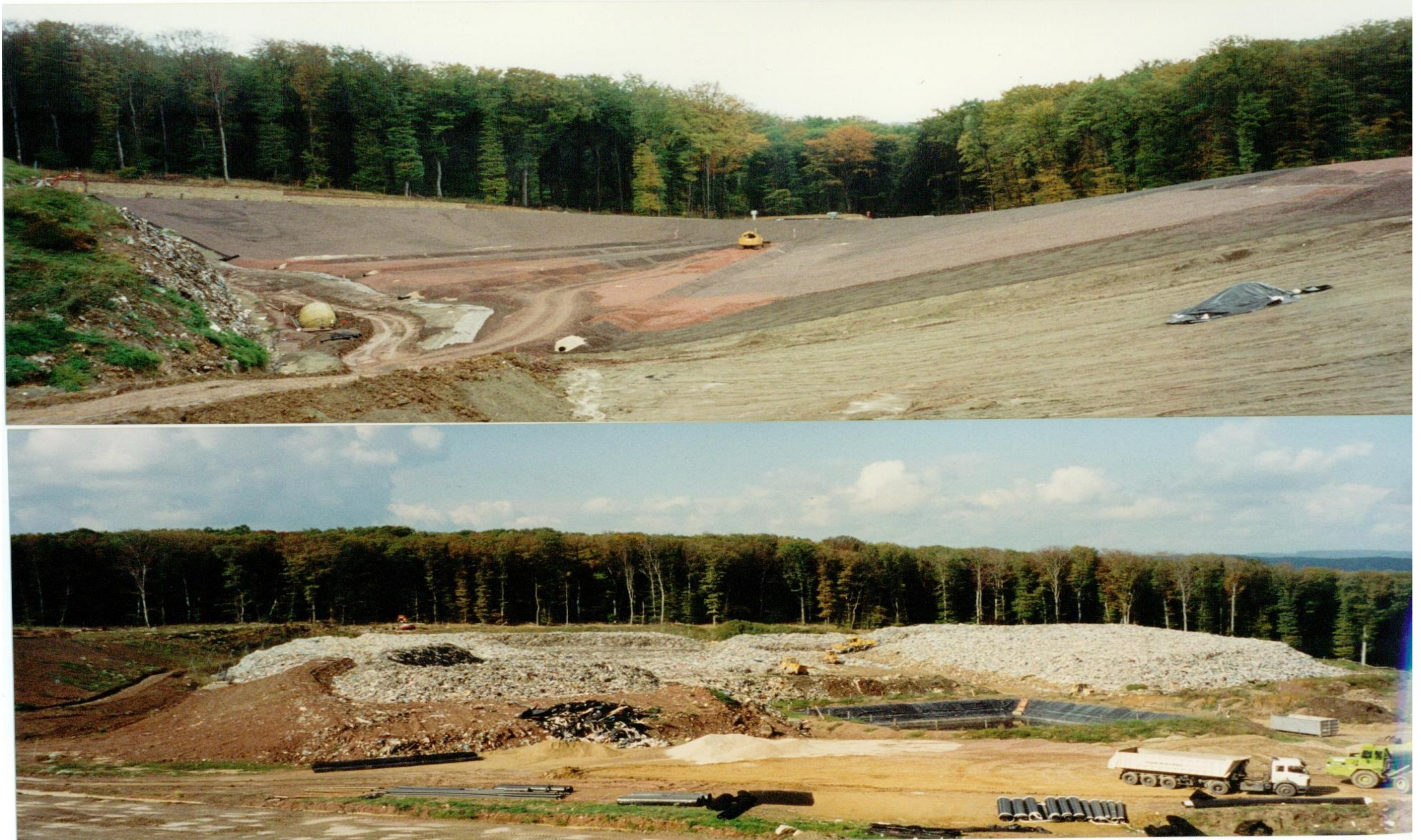
Bild 2: fertig gestellte Basisabdichtung 1. Phase der 1. Ausbaustufe (Bild oben) , angelieferte Abfälle ab 1993 zu Rottemieten aufgesetzt (Bild unten)
