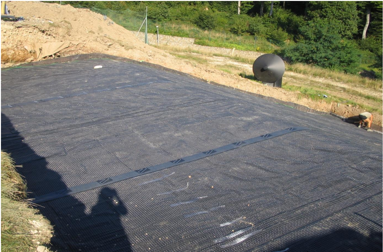
Bild 7: Untere Lage der verlegten Hohlrippendr nabahn
