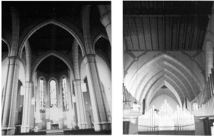
Abb. 66 u. 67: Köln-Raderthal, St. Maria Empfängnis, Blick in den Chor und auf den appgetreptten Bogen in der Westwand
