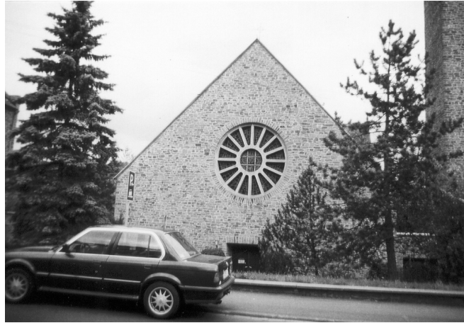
Abb. 53: Jünkerath, St. Antonius v. Padua, Westfassade
