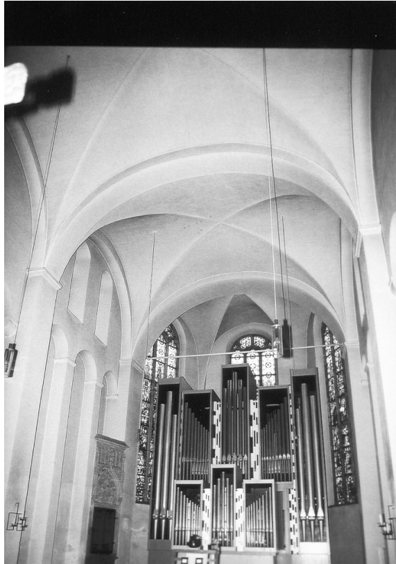
Abb. 10: Bedburg, St. Markus, Ostarm und ehemaliger Chorbereich
