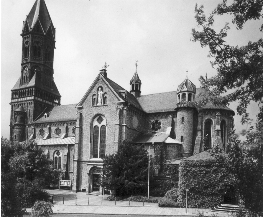
Abb. 1: Bensberg, St. Nikolaus, Ansicht von Süden
