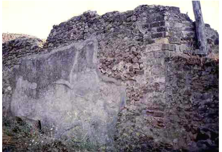
Abb. 28 - Nordostecke des Wirtschaftstraktes mit Schlitzfenster zum Raum 7,5.
