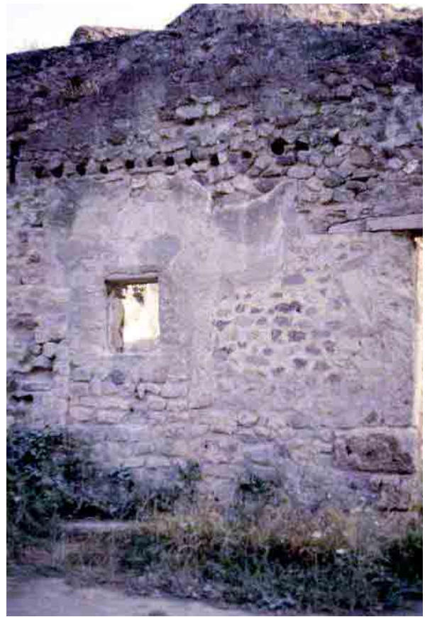
Abb. 26 - Vermauerte Tür zum Korridor ins Gartengeschloß mit Balkenlöchern eines Vordaches.
