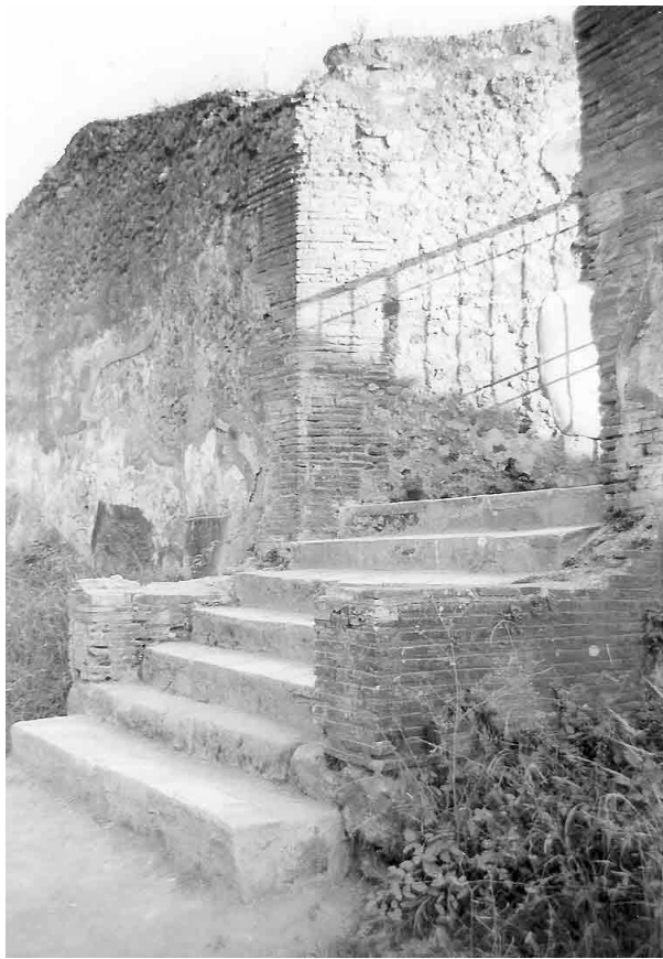
Abb. 25 - Haupteingang der Villa. Die Reste der beiden Säulen des Vordachs sind heute zerstört.
