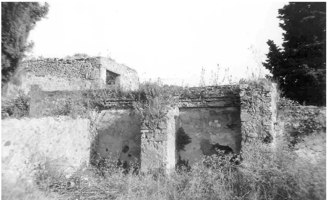
Abb. 29 - Nordostende der Portikus 5d mit umlaufendem Gesims und dagegen gesetzten, vielleicht modernen Abstützungen.
