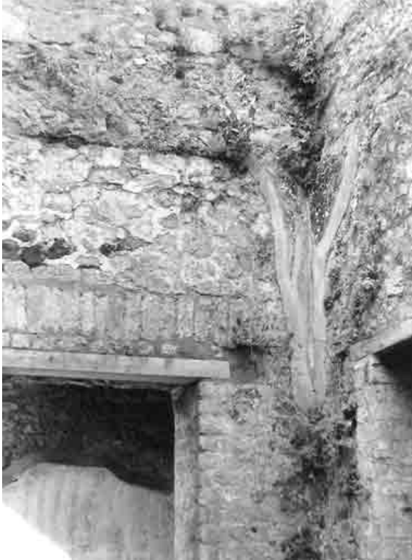
Abb. 152 - Portikus 5e. Abbruckkante der gegossenen Flachdecke in den Seitenflügeln der Halle. Links der Zugang zur Portikus 5d, rechts die Tür zum Korridor 5,12.
