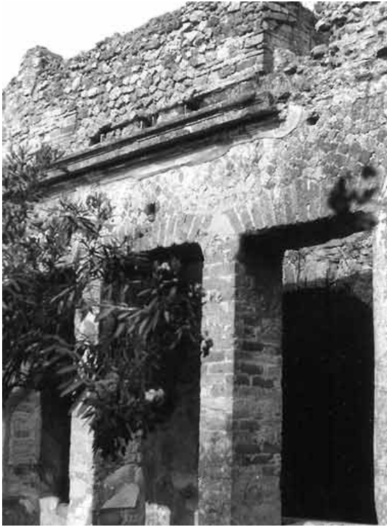
Abb. 126 - Portikus 5e mit Ansicht der Südwestecke von Saal 4,9. Über dem erhaltenen Gesims der Portikus die Balkenlöcher des Holzbodens (Balkons?) im westlichen Teil von Saal 4,9.
