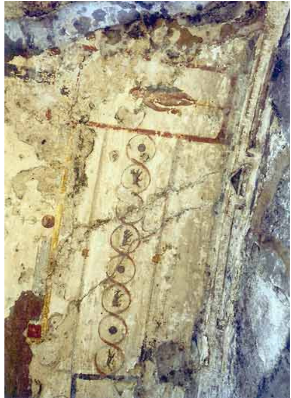
Abb. 170 - Rest der Gewölbemalerei im Osten des Saals 5,5.
