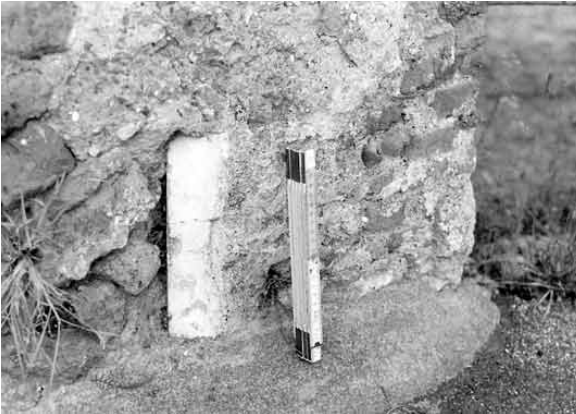
Abb. 100 - Loggia 4. Blick von Westen auf eine vermauerte Säule südlich von Raum 4,1 mit scharfkantiger dorischer Kanellur-
