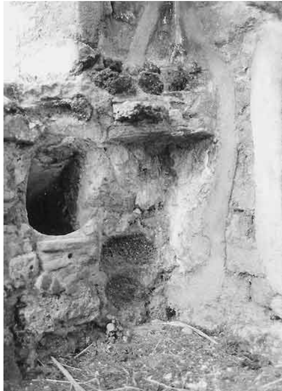
Abb. 146 - Portikus 5d. Rest des ursprünglich um die Portiken 5b-5d laufenden Gesimses am östlichen Eckpilaster und antik mit Ziegeln verengtes Schlitzfenster zum Keller 6.
