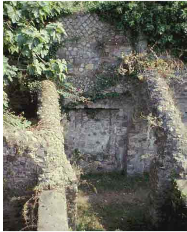
Abb. 127 - Raum 4,1bis. Reste der Südwand des heute zerstörten Pendants zu Raum 4,1. Darunter Korridor 5a mit einem großen, modern vermauertem Fenster gegenüber von Raum 5,1.
