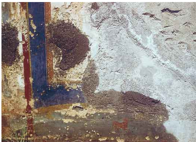
Abb. 158 - Raum 5,5. Rest des wie ein Stück Stoff aufgespannten Mittelpaneels der Nordwand. Rechts eine deutliche Pickung im Unterputz.
