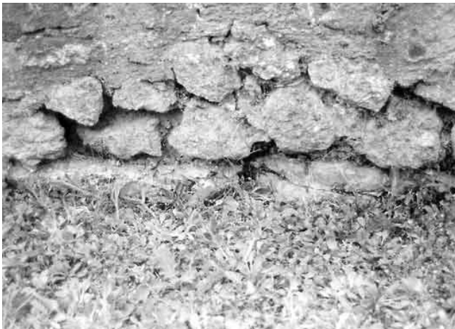
Abb. 124 - Saal 4,9. Detail der Westwand von Westen aus Loggia 4 gesehen. Die Incertummauer ist auf den ursprünglichen Estrich der Loggia 4 gesetzt (li.). In den Estrich eingelassen eine Standplatte aus Lava für die ursprüngliche Säulenstellung der Loggia (re.).
