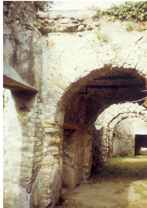
Abb. 139 - Portikus 5b von Weste mit antiken Stützbögen unter der gegossenen Flachdecke. Der vordere Bogen trägt Reste von bemaltem antiken Wandputz.
