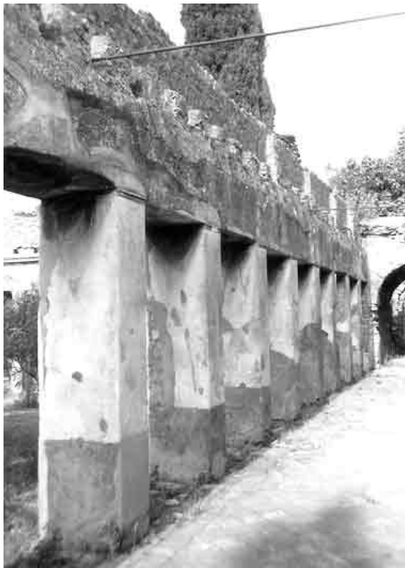
Abb. 141 - Portikus 5b mit Balkenlöchern einer antiken Holzdecke.
