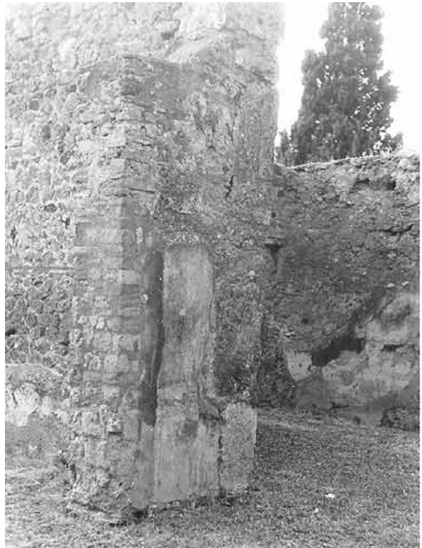
Abb. 110 - Tablinum 4,2. Blick vom Peristyl 2 auf die Nordostecke mit nachträglich angefügter Verbreiterung der Wandzunge.
