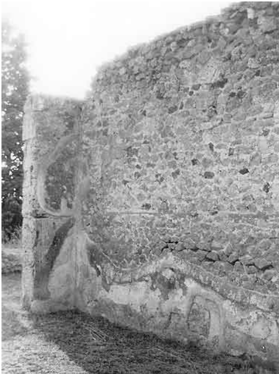
Abb. 109 - Tablinum 4,2. Nordwestecke mit Kalkquadern.
