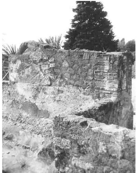
Abb. 125 - Südostecke des Saales 4,9. Links das Fenster in der Südwand des Saals. Rechts eine moderne Schutzmauer an der Abbruchkante der Loggia 4 über Raum 5,5.
