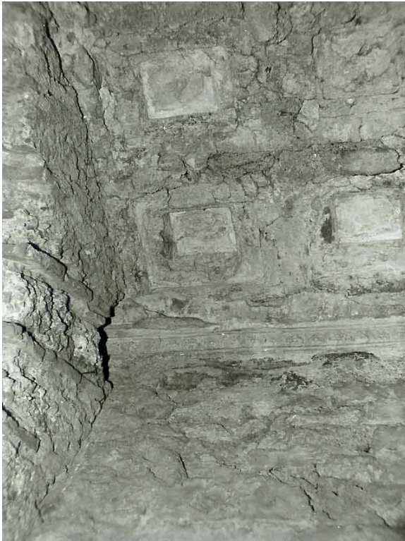
Abb. 136 - Gegossene Kassettendecke im östlichen Teil von Portikus 5b. Das Gesims der Flachdecke läuft unter dem angesetzten Stützbogen durch.
