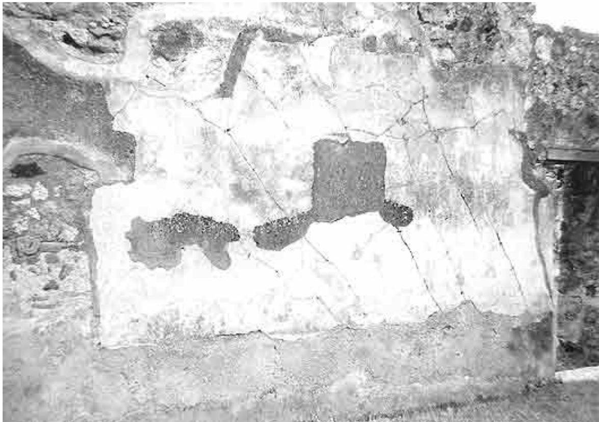
Abb. 115 - Tablinum 4,2. Südwand mit großer Fehlstelle, an der das Mittelbild entfernt wurde. Die modern ausgeputzte Stelle ist wesentlich größer als die auf dem Kupfer der „Gli Ornati“ wiedergegebenen Tondi.
