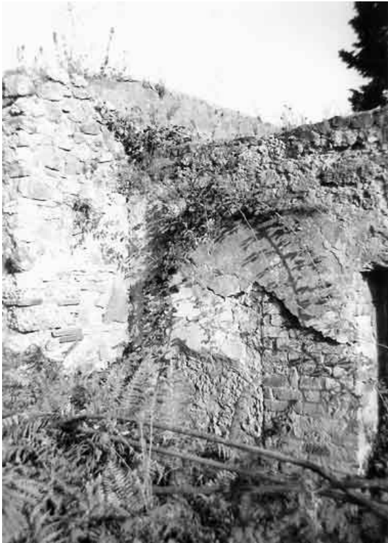
Abb. 145 - Portikus 5d. Antik vermaueretes Fenster in Höhe der Portikus 5e und modern geöffnetes Fenster rechts daneben.
