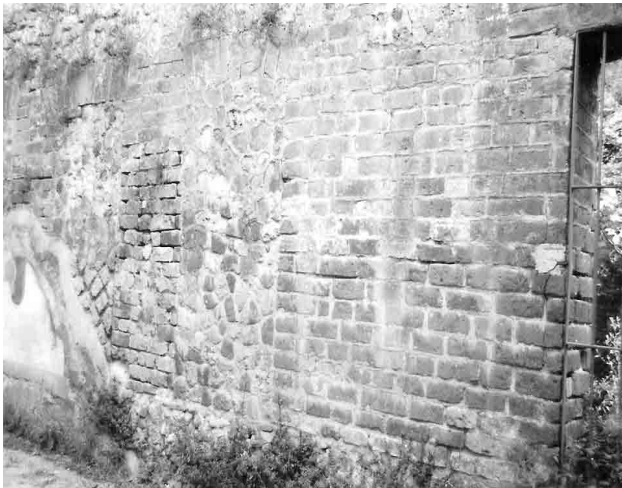
Abb. 138 - Westende von Portikus 5b mit der Tür nach Raum 5,2 (re.) und zwei antik zugesetzten Fenstern (li.), die im ursprünglichen Bauzustand der luftigen Gartenportikus den Blick frei gaben auf den Garten der Villa im Süden und den Hafen von Pompeji in der Ferne am Fuß des Stadthügels.
