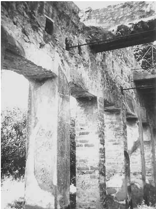
Abb. 128 - Portikus 5e mit darüber liegender Südwestecke von Saal 4,9. Links moderne Balkenlöcher, daneben die höher liegende Balkenlöcher des antiken Fußbodens des westlichen Teils von 4,9.
