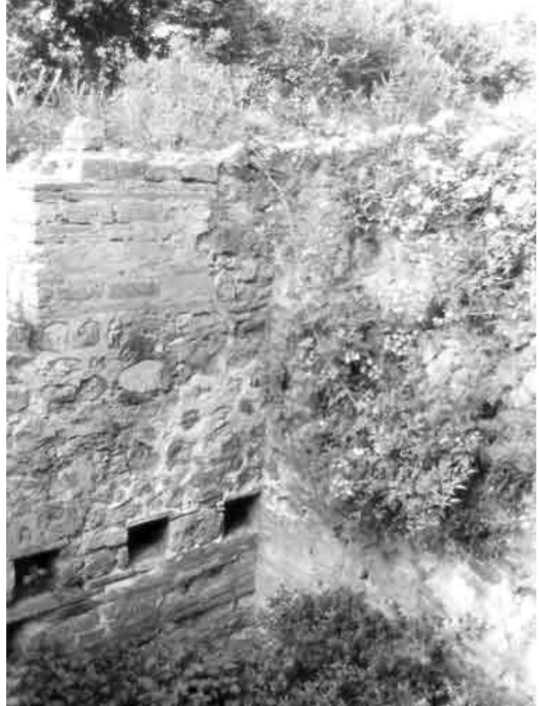
Abb. 153 - Nordostecke von Raum 5,2bis. Unter den quadratischen Balkenlöchern in der Nordwand der Ansatz einer Tür oder eines Fensters zum heute unzugänglichen Untergeschoß des Raumes.
