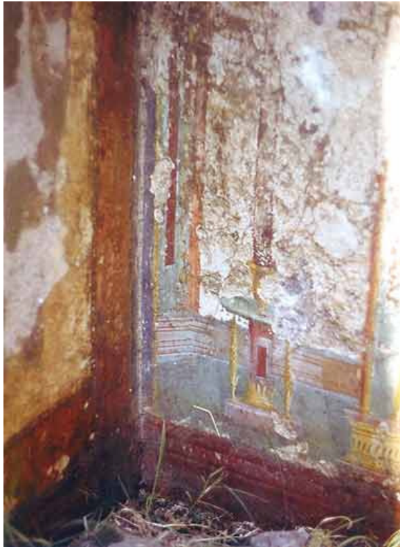
Abb. 156 - Raum 5,5. Nordwestecke mit reichem Architekturdurchblick und kostbar gestaltetem Pflanzenkandelaber.
