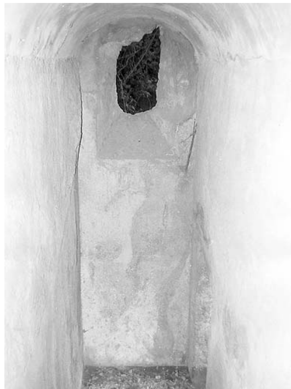
Abb. 122 - Treppenhaus 4,6. Blick von Norden auf die Südwand mit Oberlichtfenster und die Tür zu den Räumen des Gartengeschosses am Fuß der Treppe.
