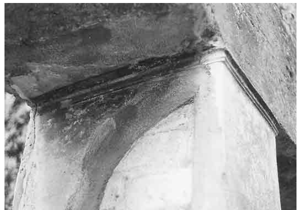
Abb. 142 - Portikus 5b. Stuckkapitell der Pilaster.
