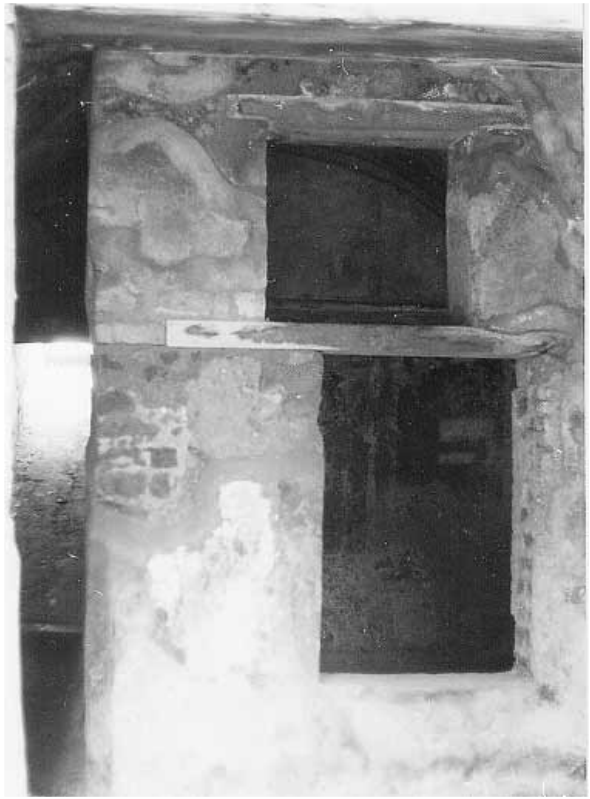
Abb. 241 - Blick von Westen auf den nachträglich in den Raum 5,12 eingefügten kleinen Raum 5,13.
