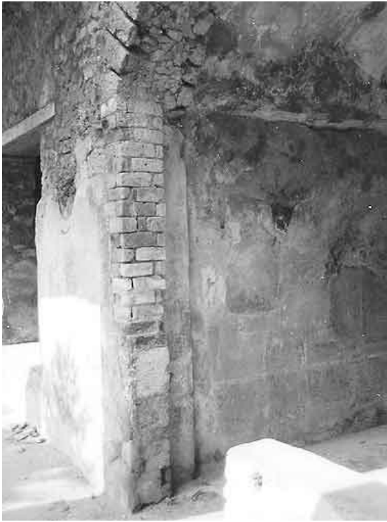
Abb. 177 - Blick aus Portikus 5e in den Raum 5,7. Die große Bogenöffnung gibt auf voller Breite den Blick frei auf den Garten. Die kleine Brüstungsmauer (re.) spricht für eine ehemalige Verglasung der Raumöffnung.
