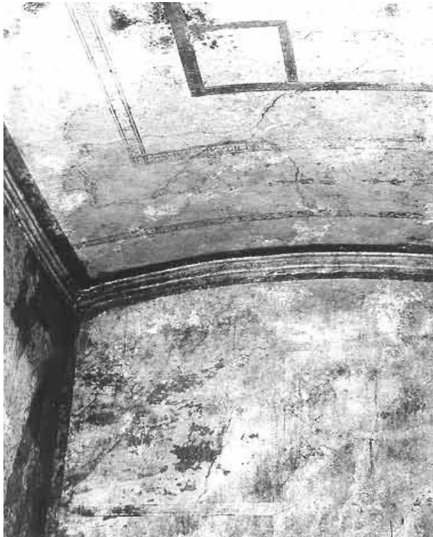
Abb. 248 - Raum 5,13. Südostecke. Lünette über dem linken Wandfeld der Ostwand. Die unvollständige Lünette entstand durch das nachträgliche Einziehen der Nordwand des Raumes in einen bereits vorhandenen größeren Gewölberaum.
