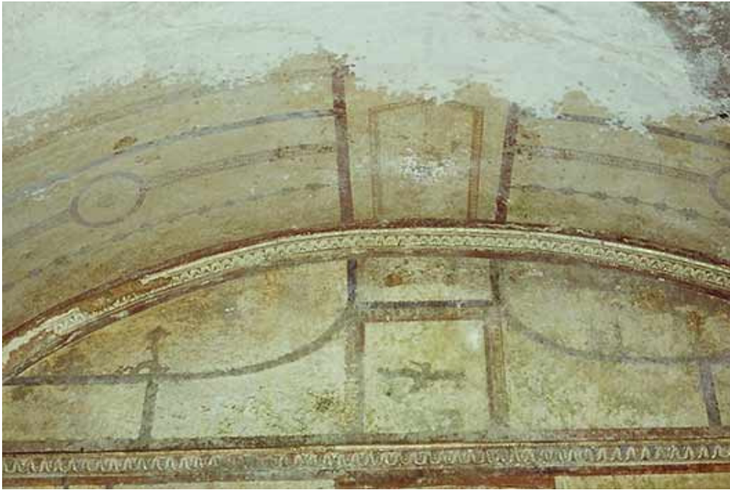
Abb. 216 - Raum 5,9. Ansatz der Gewölbedekoration über der Lünette der Ostwand.
