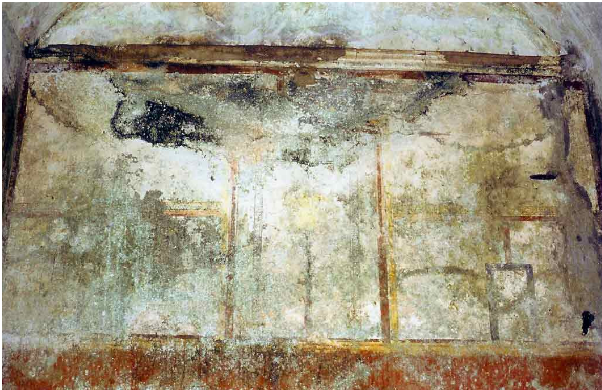
Abb. 196 - Zugangsraum 5,8. Oberzone und Lünette der Ostwand. Deutlich erkennbar der in die Oberzone ragende Mittelkandelaber, der von einer gelben Kugel bekrönt wird.
