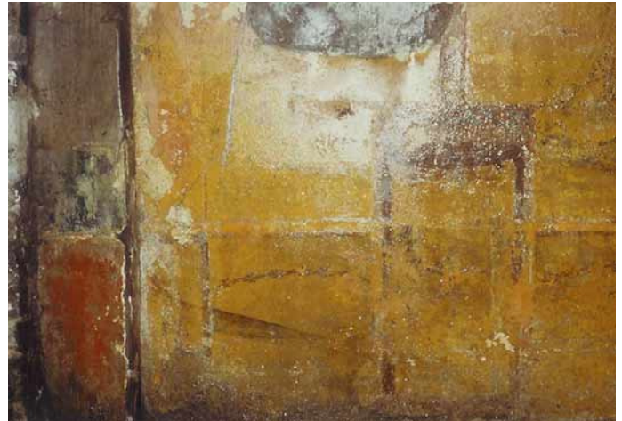
Abb. 178 - Sockelbereich des nordwestlichen Bereichs der Nordwand. Links die andersfarbig gestaltete Laibung der großen Bogenöffnung im Westen. Die schmale Sockelädikula wird von einem vertikalen Ornamentband bekrönt, das ehemals das Mittelbild des linken Wandpaneels der Nordwand trug.
