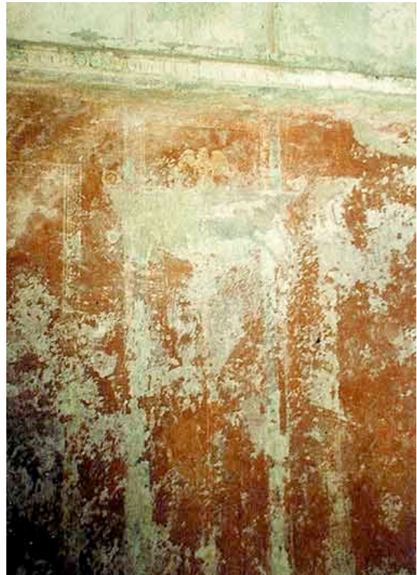
Abb. 245 - Raum 5,13. Die stark beschädigte Mittelarchitektur der Ostwand.
