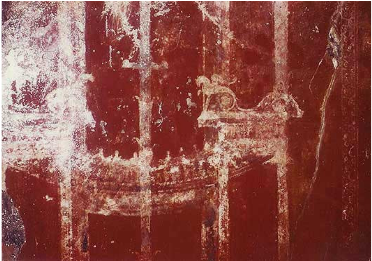
Abb. 258 - Raum 5,13. Nordwand. Halbkreisförmiges Gebälk der stark verblassten Mittelädikula mit Greifenakroteren.
