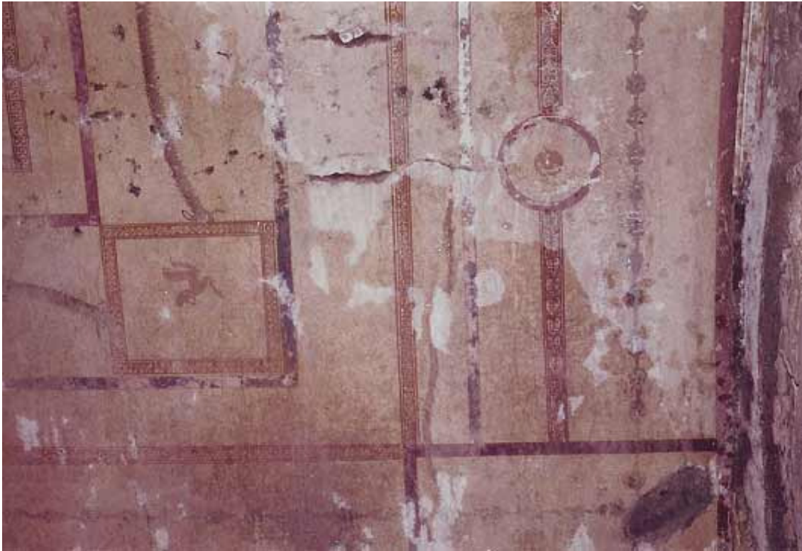
Abb. 220 - Raum 5,9. Südwestecke der Gewölbedekoration.
