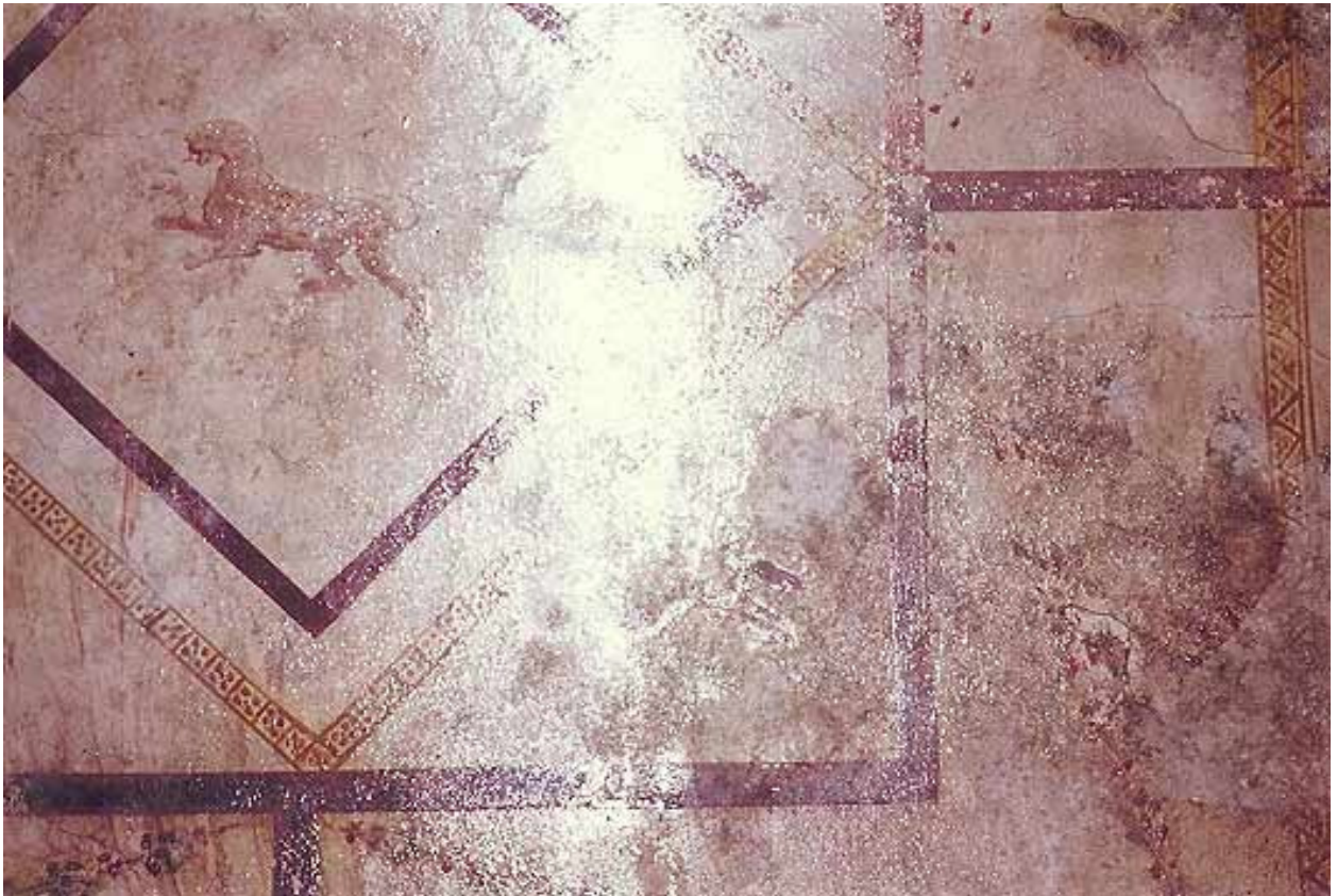
Abb. 267 - Raum 5,13. Mittelembem der Decke mit geflecktem Panther. Deutlich sichtbar der Rest der gelben Farbe, mit der die filigranen roten Ornamentborten ehemals unterlegt waren.
