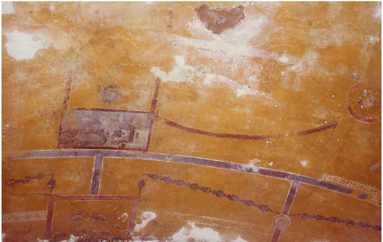
Abb. 191 - Raum 5,7. Ansatz der Scheitelzone der Gewölbedekoration an der Rückwand im Osten.
