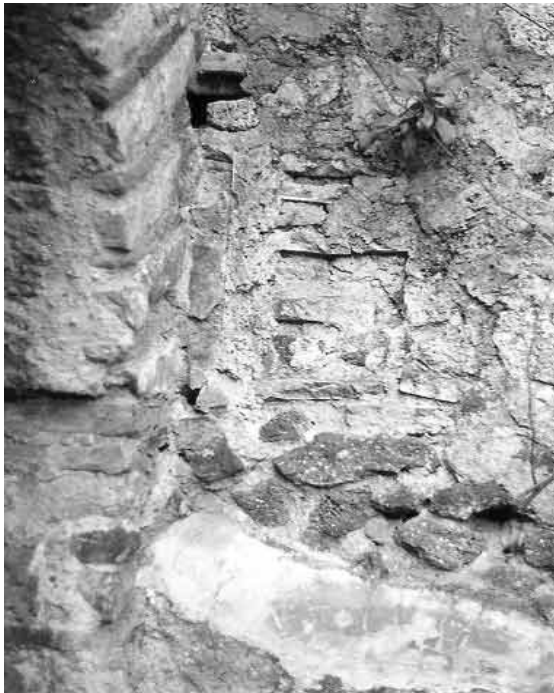
Abb. 292 - Vermauertes Schlitzfenster in der Westwand von Raum 7,8. Links der gegen die Wand gesetzte Stützbogen mit Resten seines Putzes.
