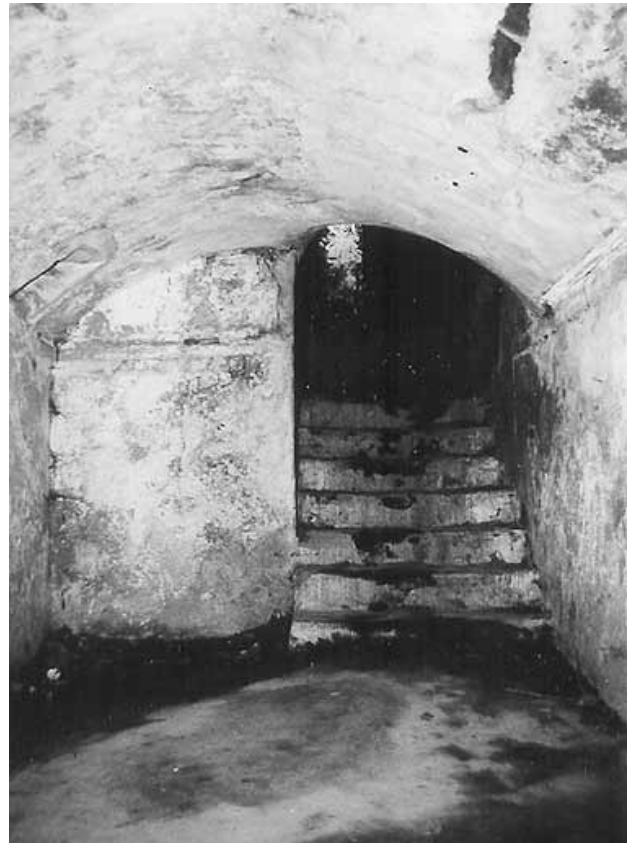
Abb. 273 - Blick von Westen auf den Zugang zum Nordflügel von Keller 6. Am Fuß der Kellertreppe fand man die Leichen der Bewohner der Villa auf der eingedrungenen Vulkanasche liegend, die ihnen den Ausgang ins Freie versperrt hatte.
