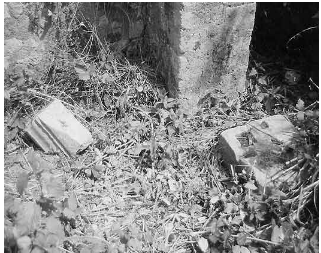
Abb. 285 - Hof 7,6a. Marmorspolien im Bereich des kleinen überwölbten Kellergangs unter Raum 7,1/7,2 (re.). Daneben ein modern angesetzter Stützpfeiler in Verlängerung der Nordwand von Raum 7,1/7,2.
