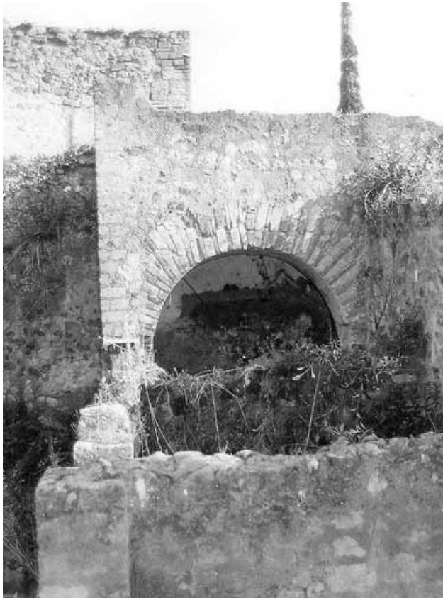
Abb. 290 - Blick von Norden auf die westlichen Räume des Wirtschaftstraktes. Im Hintergrund der moderne (?) Stützbogen unter dem östlichen Ende der Terrasse A.
