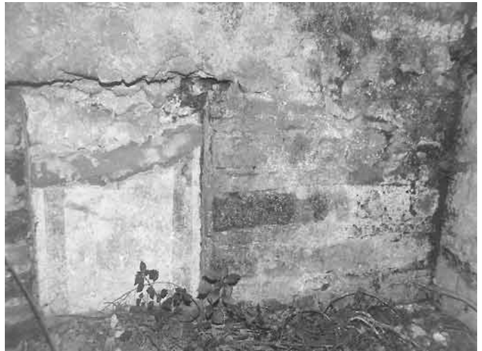
Abb. 293 - Raum 7,8. Flache Wandnische in der Mitte der Südwand des Raumes. Die Nische trägt noch ihren weißen Innenputz mit einer breiten roten Rahmung.
