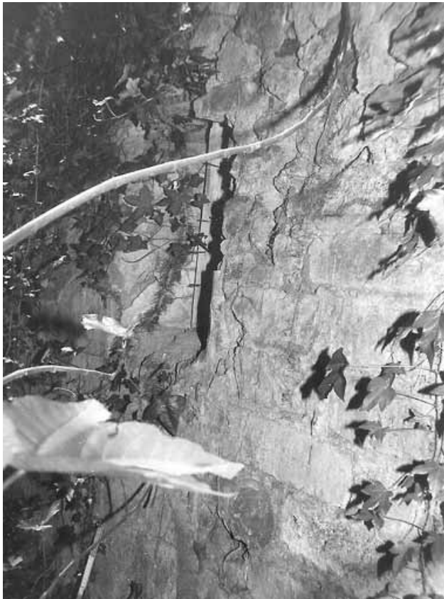
Abb. 279 - Nordwand von Gang 6b. Vermauertes Schlitzfenster in Höhe des Raumes 7b. Das Fenster verjüngt sich nach Norden, von woher es sein Licht bekam.
