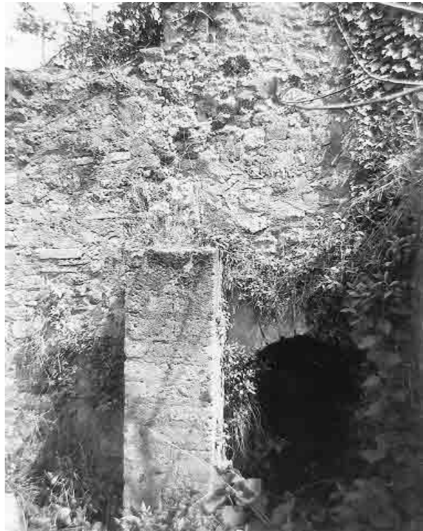
Abb. 287 - Raum 7,6a. Ostseite des nachträglich in den Hof 7,6 eingebauten Raumes mit Zugang zum Kellergang unter Raum 7,1/7,2. Der Stützpfeiler daneben ist modern.
