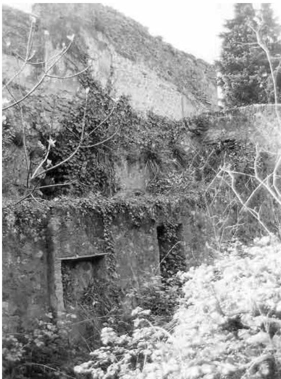
Abb. 288 - Blick auf die Südseite des Hofes 7,6 mit der Nische von Raum 7,6a (li.) und dem vermauerten Fenster zum Gang 6b in Raum 7,6b. Dahinter die hoch aufragende Nordwand des Hauptgebäudes.
