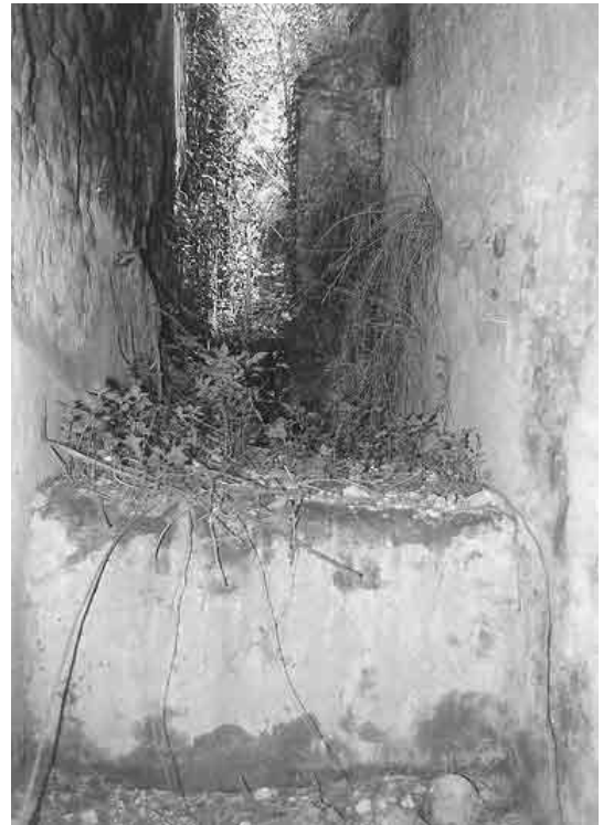
Abb. 276 - Zugangsraum 6a zum Keller. Gemauerte Stufe als Begrenzung zum Gang 6b im Osten.
