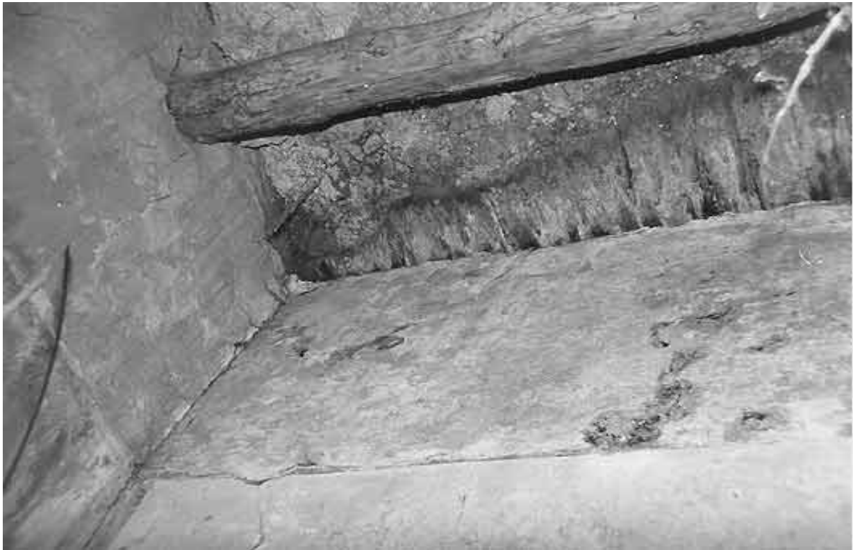
Abb. 294 - Südostecke von Raum 7,8. Wandoberzone mit moderner Bretterdecke zum Unterfangen der darüber liegenden Terrasse A. Der in der Ecke von einer roten Leiste eingefasste antike Weißputz der Wände endet mit einer geraden Horizontalkante. Darüber ein gröberer Verputz, der bis zu der auf ihrer Unterseite ebenfalls verputzten Bretterdecke unter der Terrasse A reicht.
