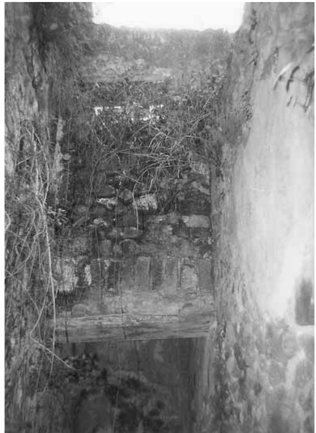
Abb. 278 - Gang 6b. Westende mit Holzsturz über der Stufe zum Kellerzugang 6a. Darüber das durch den Estrich der Terrasse A halb zugesetzte Fenster.
