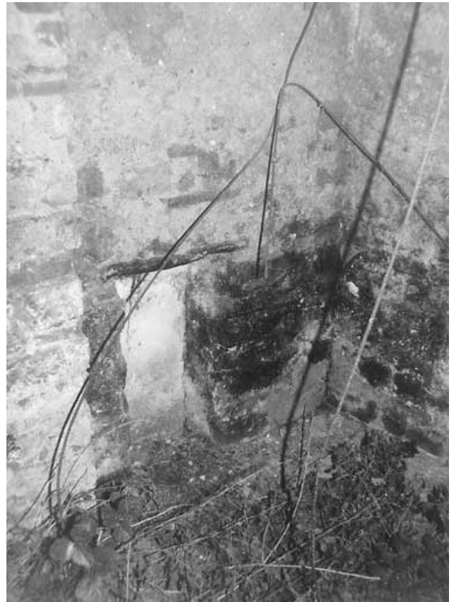
Abb. 291 - Südostecke von Raum 7,8 mit einer verputzten Wandnische. Links der Stützpfeiler, der die über der südlichen Hälfte des Raumes liegende Terrasse A unterfängt.
