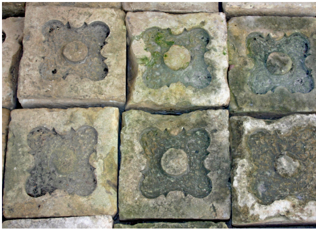
Abb. 15: Fußbodensteine im Innenhof, 1. Hälfte 18. Jahrhundert, Franziskanerkonvent, Parafba.
