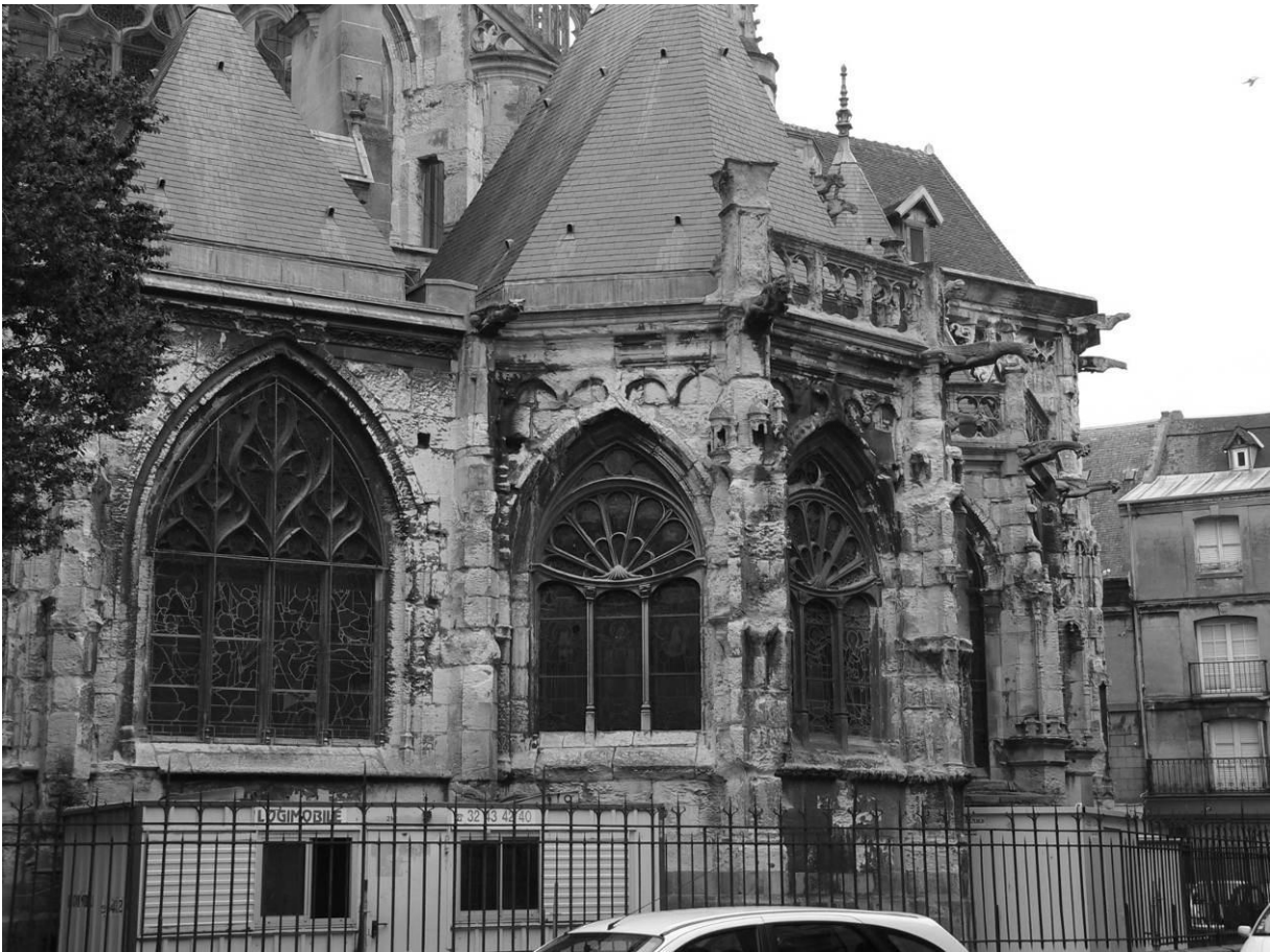
Abb. 217: Dieppe, Saint-Jacques, südwestl. Chorkapelle v. SW.
