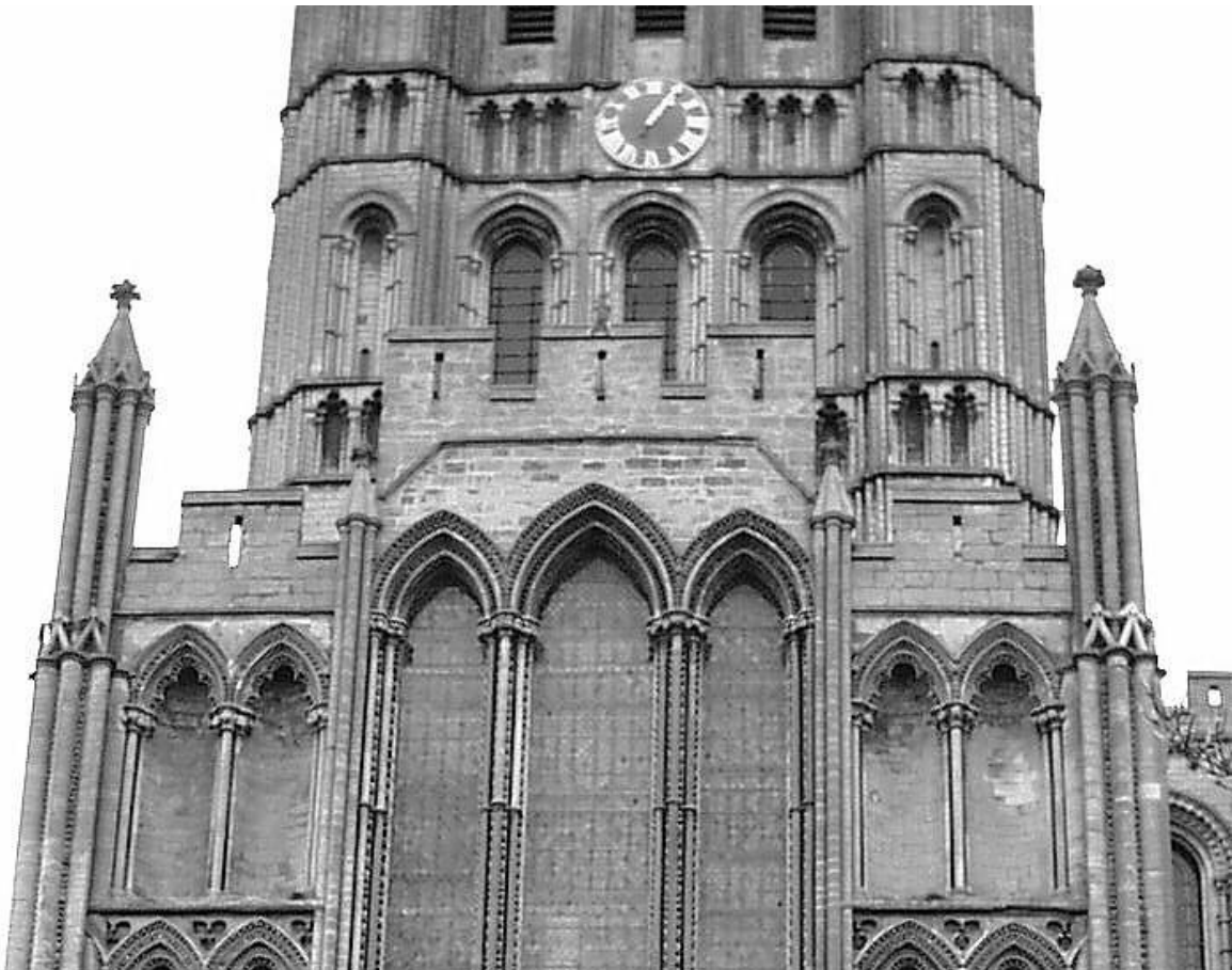
Abb. 172: Ely, Kathedrale, Westturm
