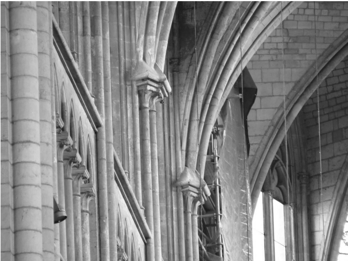
Abb. 115: Rouen, Notre-Dame, Chorobergaden, Nordseite, Vorlage e3n/e4n
