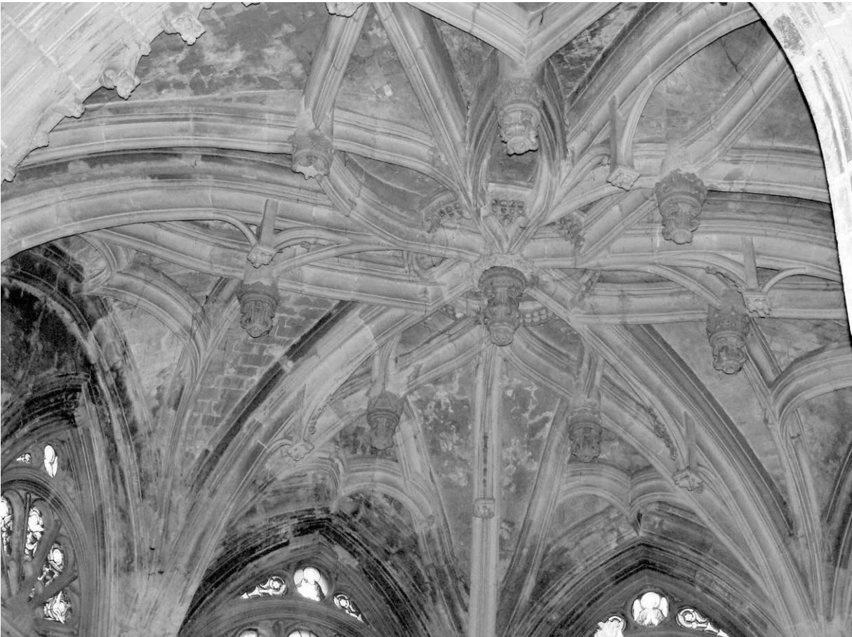
Abb. 252: Dieppe, Saint-Jacques, Chapelle des Guillebert, Gewölbe n. SO.
