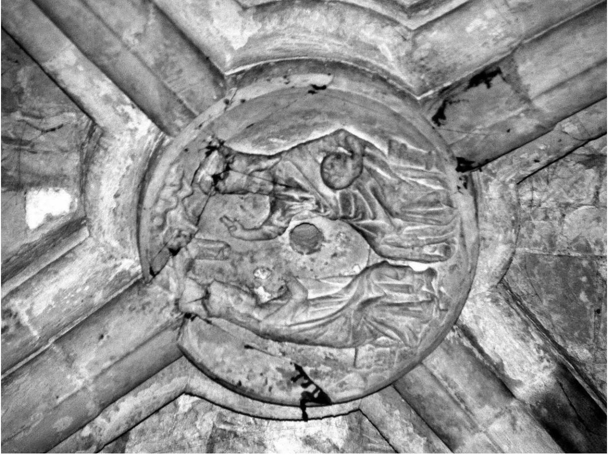
Abb. 233: Dieppe, Saint-Jacques, nördl. Chorumgang EINI, Schlussstein
