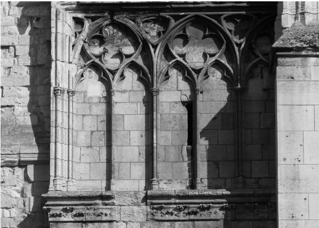
Abb. 106: Rouen, Notre-Dame, Verbindungsbau zwischen Westfassade und Romanusturm v. W.
