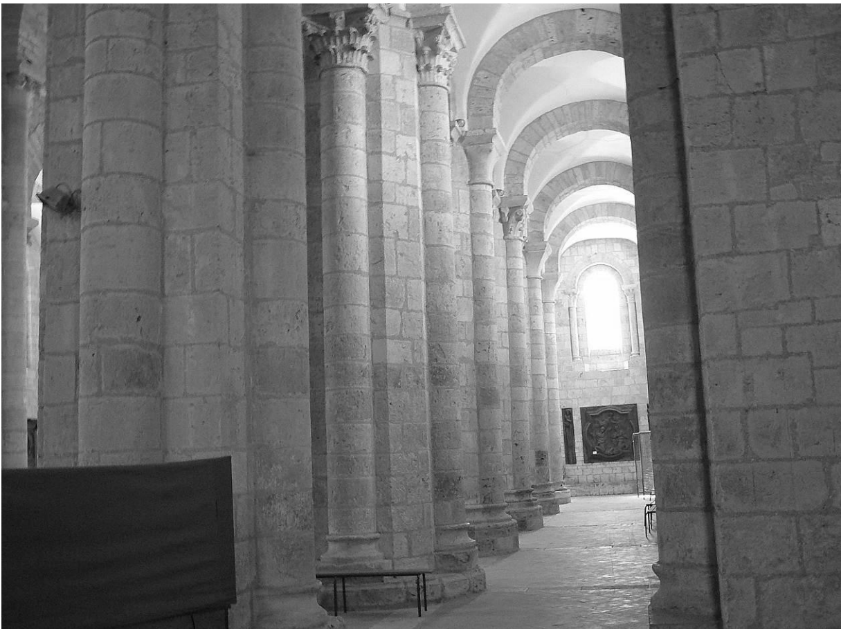
Abb. 50: Moirax, Prioratskirche Notre-Dame, südl. Seitenschiff n. W.
