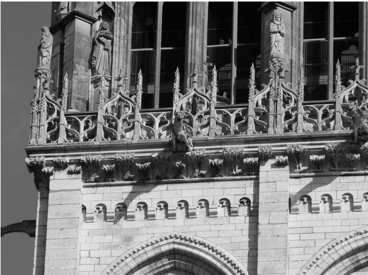
Abb. 40: Rouen, Notre-Dame, Tour Saint-Romain, Obergeschoss, Brüstung v. W.
