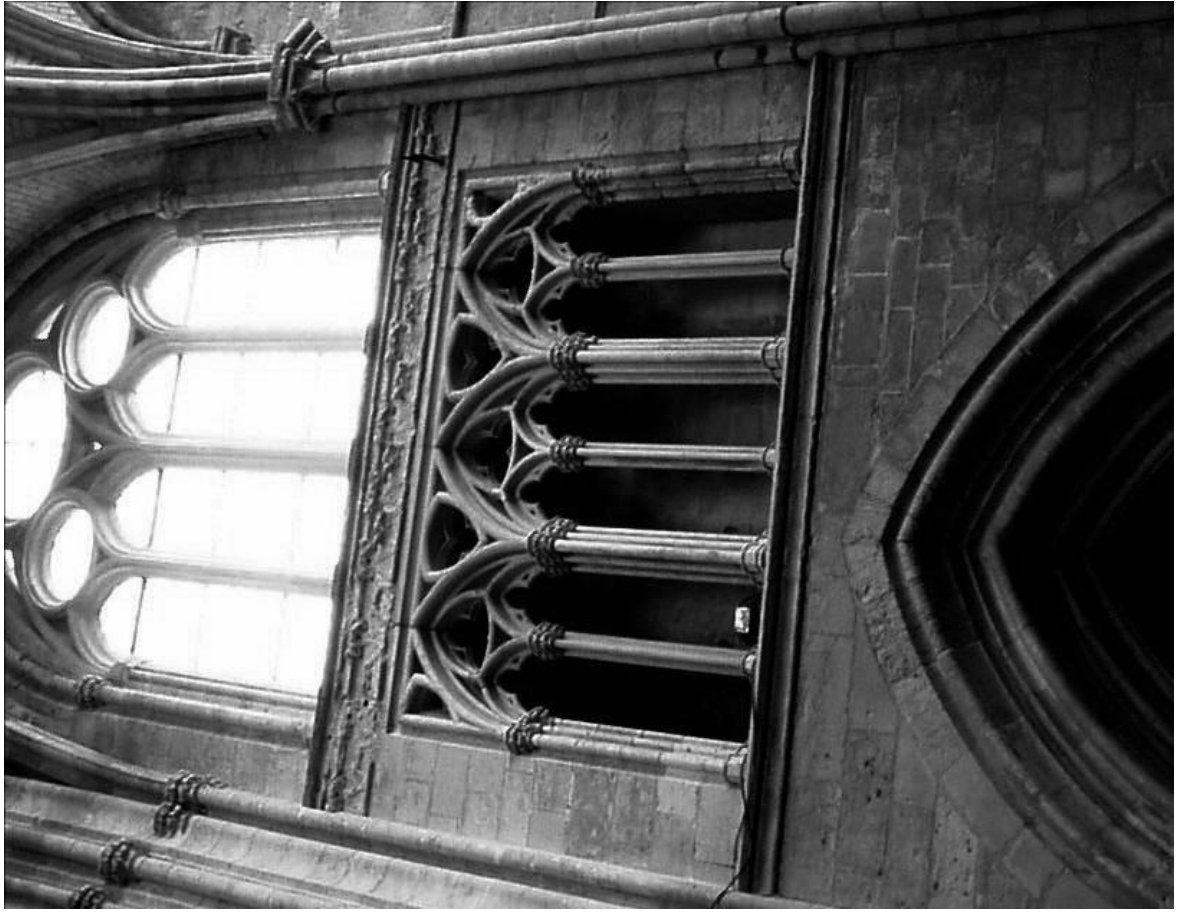
Abb. 209: Dieppe, Saint-Jacques, NI, westl. Obergadenfenster
