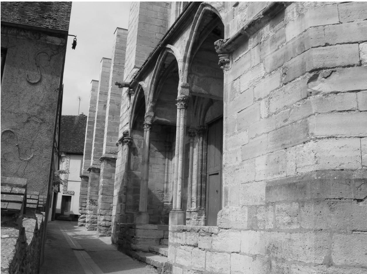
Abb. 142: Saint-Julien-du-Sault, Saint-Pierre, Langhaus, südl. Vorhalle v. SO.
