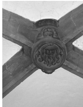
Abb. 328: Heusweiler, ev. Pfarrkirche, Gewölbe im Chor
