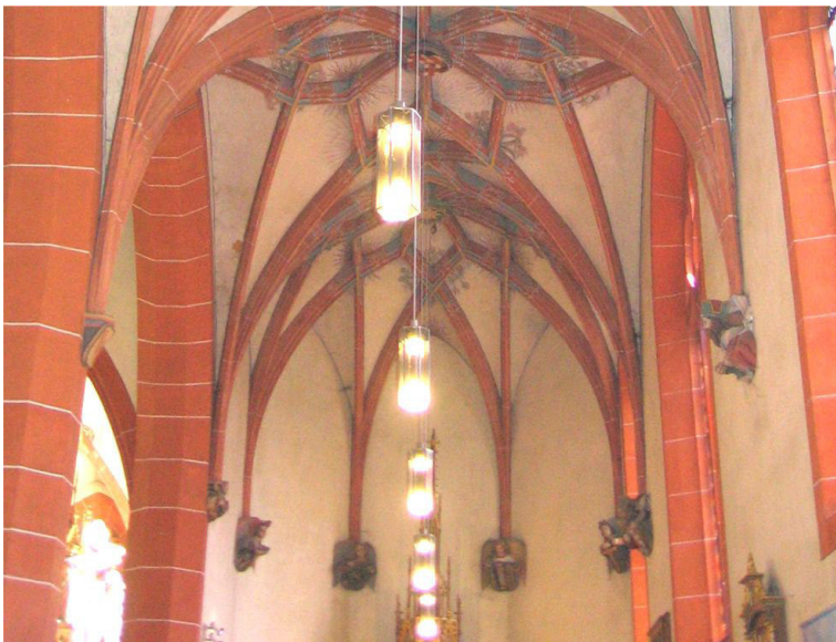
Abb. 375: Kettig, St. Bartholomäus, Gewölbekonsolen im Chor des Seitenschiffs
