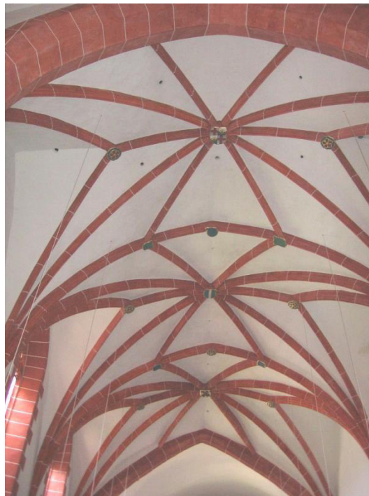
Abb. 271: (Saarburg-)Beurig, St. Mariä Heimsuchung, Gewölbe im Hauptschiff
