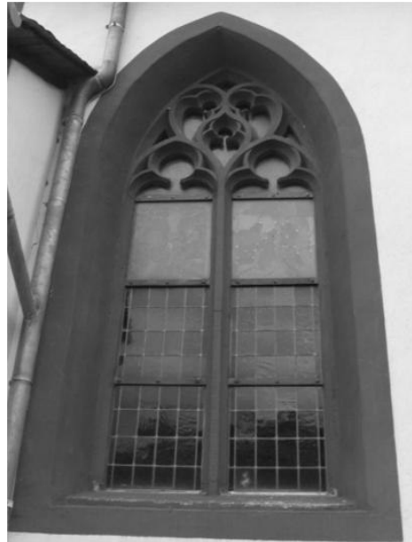
Abb. 237: Hatzenport, St. Johannes, Fenster am Langhaus
