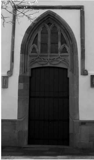
Abb. 251: Kölln, ev. Pfarrkirche, Westportal
