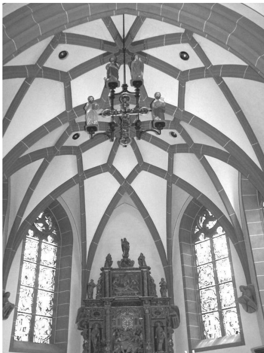
Abb. 265: Bremm, St. Laurentius, Gewölbe im Chor
