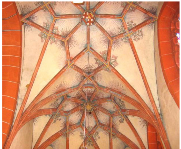
Abb. 359: Kettig, St. Bartholomäus, Gewölbe im Seitenschiff nach Osten
