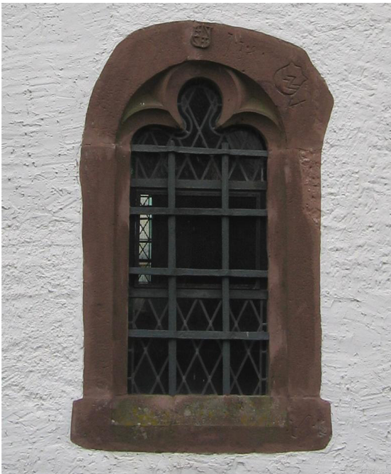
Abb. 80: Gransdorf, St. Appolonia, Detail eines Fensters
