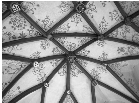
Abb. 366: Niederwiltz, St. Peter und Paul, Gewölbe im Chor
