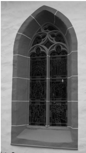
Abb. 238: Westerburg, ev. Pfarrkirche St. Dionysius, Fenster am Langhaus
