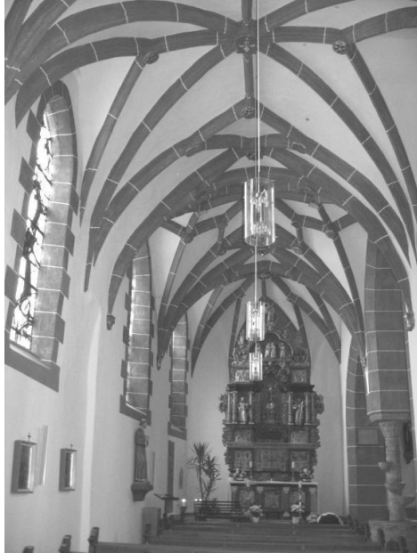
Abb. 303: (Saarburg-)Beurig, St. Mariä Heimsuchung, Gewölbe im Seitenschiff
