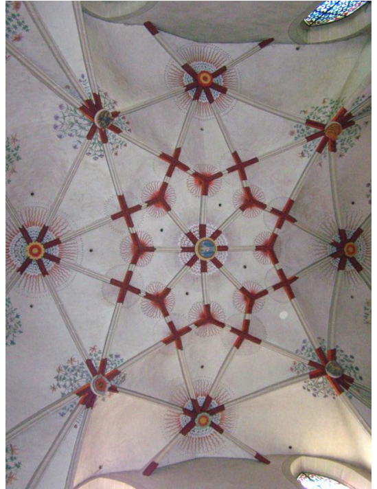
Abb. 378: Koblenz, St. Kastor, Gewölbejoch im Langhaus
