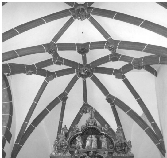
Abb. 358: (Saarburg-)Beurig, St. Mariä Heimsuchung, Gewölbe im Chor
