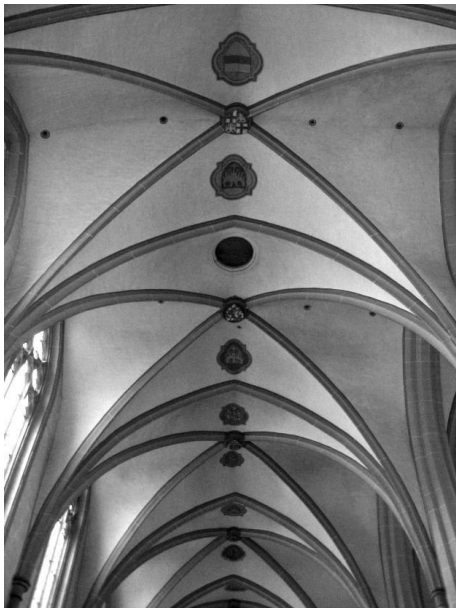
Abb. 365: Andernach, Minoritenkirche, Gewölbe im Langhaus
