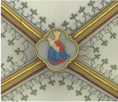
Abb. 342: Boppard, ehem. Karmeliterkirche, Gewölbe im Langhaus
