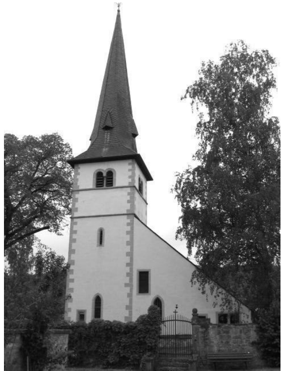
Abb. 147: Wolsfeld, alte kath. Pfarrkirche, Außenansicht von Westen
