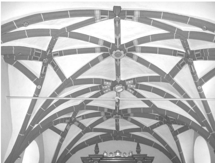
Abb. 300: Fliessem, kath. Pfarrkirche Kreuzerhöhung, Gewölbe im Langhaus
