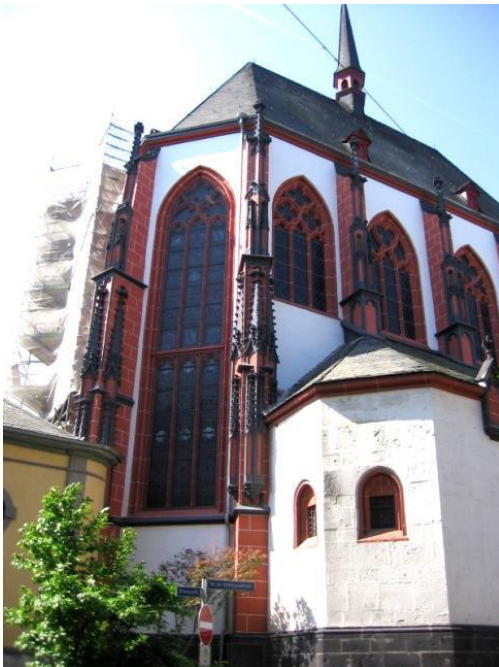
Abb. 222: Koblenz, Liebfrauenkirche, Außenansicht des Chores
