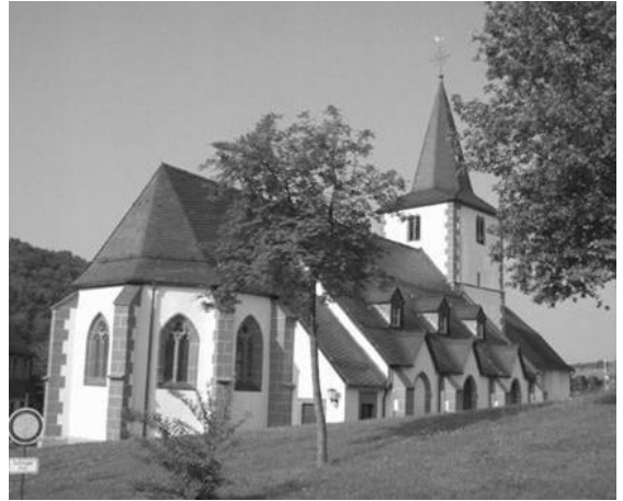
Abb. 204: Niederbrombach, ev. Pfarrkirche, Außenansicht von Osten
