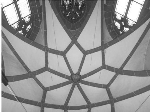
Abb. 280: Treis, St. Katharina, Gewölbe im Chor
