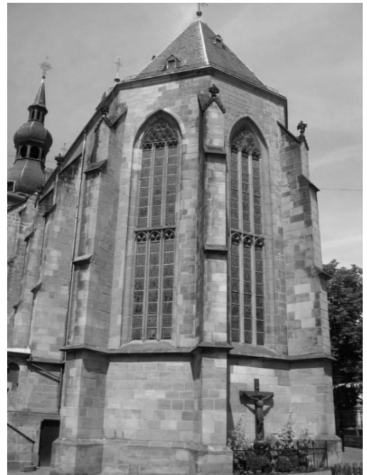
Abb. 223: St. Wendel, St. Wendalinus, Außenansicht des Chores
