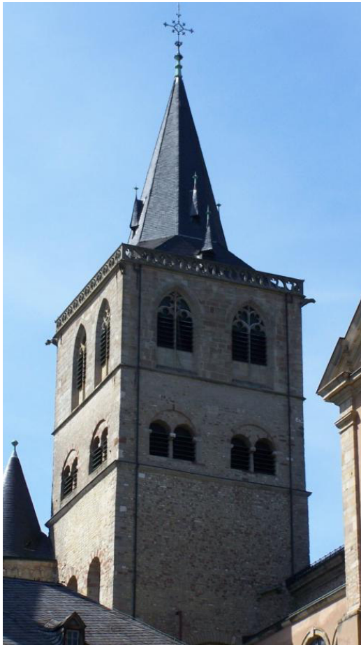
Abb. 15: Trier, Dom, Südwestturm
