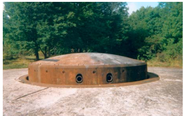
Foto 32: Galopin-Panzerturm, Batterie de l'Eperon (bei Nancy)
