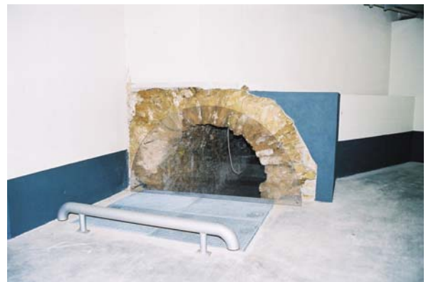
Foto 89: Erhaltung von Relikten des Fort Lambert (Luxemburg) in der Tiefgarage Monterey
