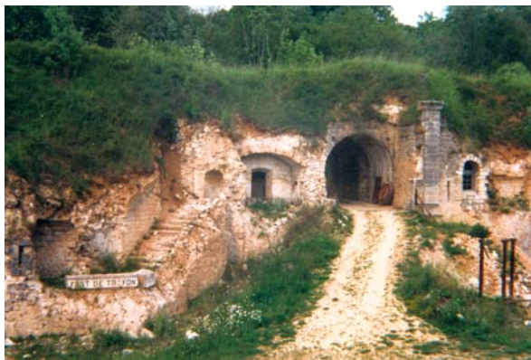
Foto 347: Durch den Krieg zerstörter Eingangsbereich des Fort Troyon (Meuse)
