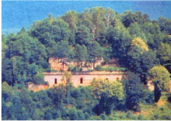
Foto 345: Ansicht des Fort San Sebastian vor den Instandsetzungsarbeiten Quelle: ROBIN/LEICHTNAM 2001, S.112
