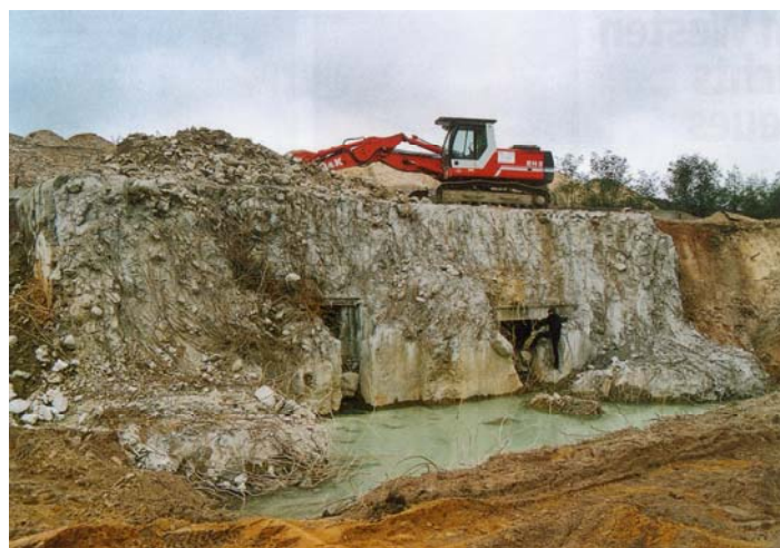
Foto 1: Abriss eines Westwallbunkers bei Ensdorf im Saarland Quelle: FUHRMEISTER, 2003, S.199
