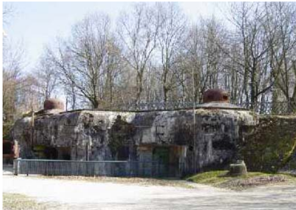
Foto 258: Der Eingangsblock des Infanteriewerkes Bambsch
