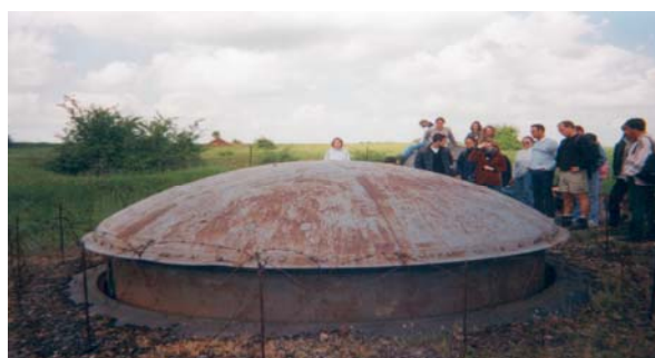
Foto 238: Geschützturm des Kampfblocks 1 (Fermont)
