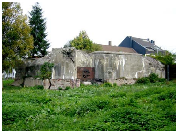
Foto 323: Bunker 11, Doppel-MG-Kasematte in Dillingen
