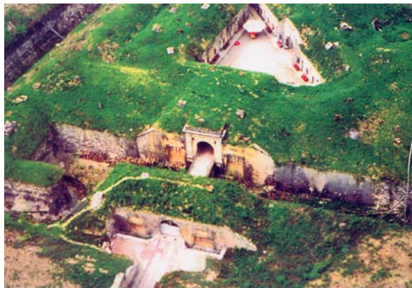
Foto 199: Der Eingangsbereich des Fort de Bourlémont mit Ravelin, Brücke und Dreieckshof
