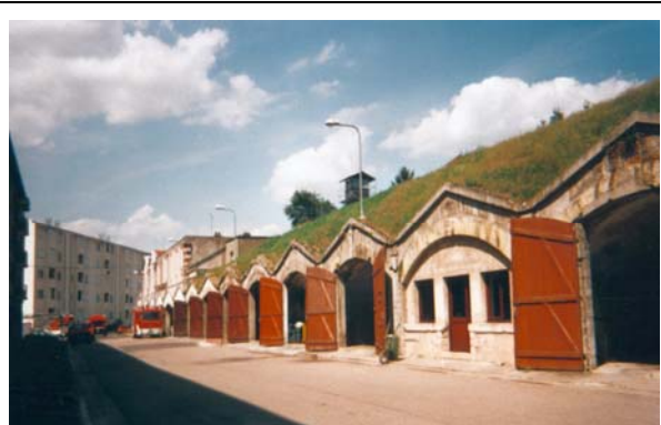
Foto 129: Von der Feuerwehr genutzte Kasematten in Toul aus der Zeit von Séré de Rivières
