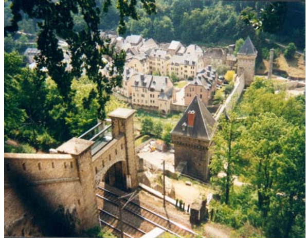
Foto 94: Eisenbahntor mit den beiden Vaubanttürmen im Hintergrund (Luxemburg)
