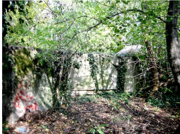
Foto 319: Der Bunker 31, „Fleury“ in Dillingen
