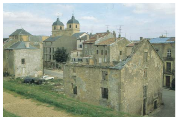
Foto 52: Teilweise verfallene Häuser im Inneren der Zitadelle von Montmédy
