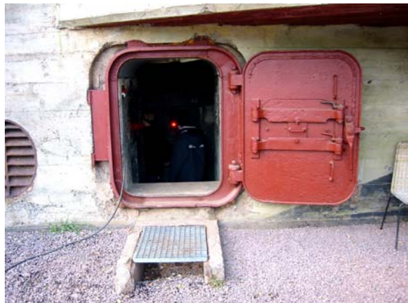
Foto 307: Eingang des B-Werkes Besseringen
