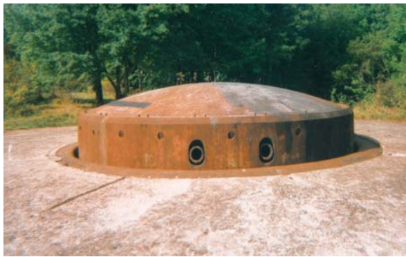
Foto 201: Der 155er Galopin-Panzerturm in der Batterie de l'Eperon
