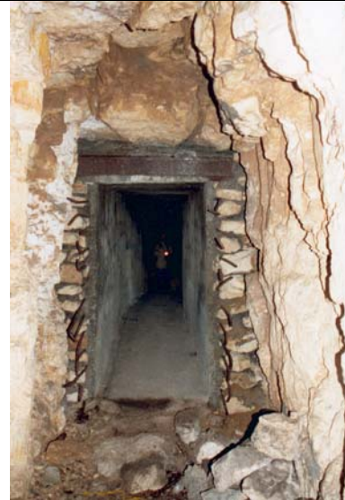
Foto 164: „Galleries 17“ im Fort Landrecourt
