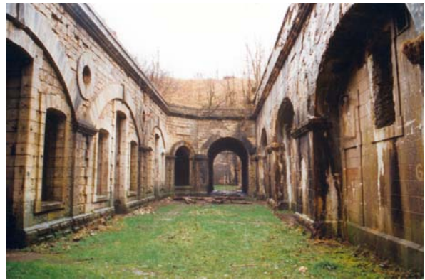
Foto 152: Der Kaserneninnenhof des Fort Rozelier
