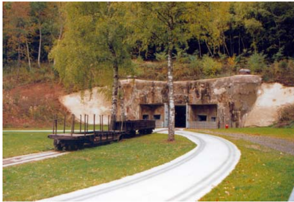
Foto 264: Munitionseingang des Simserhofes
