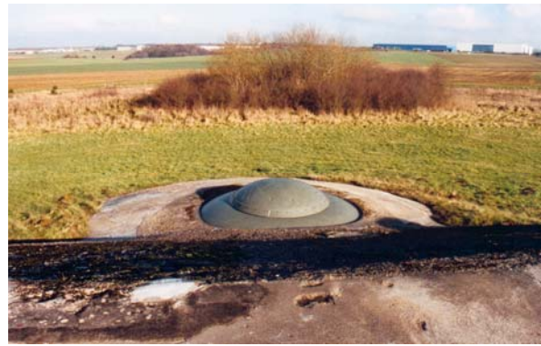
Foto 241: Der Maschinengewehrpanzerturm des Werkes Bois du Four
