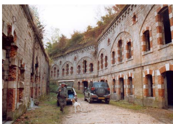
Foto 167: Die zweistöckige Kaserne des Fort La Chaume mit Jägern, die diese als Unterstand nutzen
