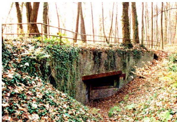
Foto 292: Der Eingangsbereich des Interfest-Bunkers am Halberg/Saarbrücken
