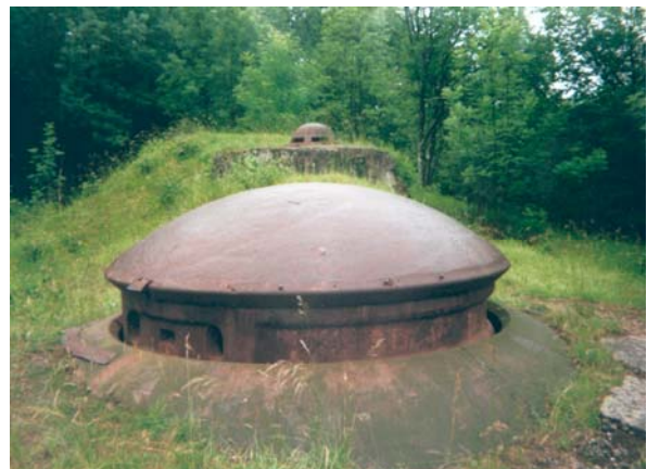
Foto 34: 75er Panzerturm mit Beobachtungsstand, Fort Liouville (bei Commercy, Meuse)
