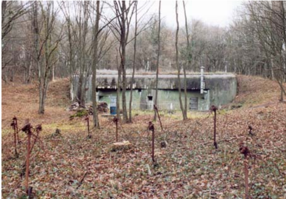
Foto 266: Ansicht des Unterstandes Bichel Sud mit Infanteriehindernis im Vordergrund
