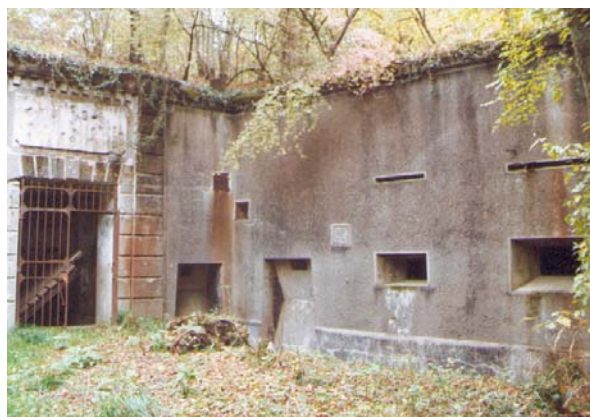
Foto 165: Eingangsbereich des Fort Déramé mit der hochgestellten Brücke
