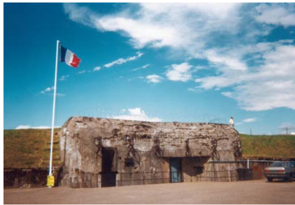
Foto 262: Der Eingangsblock des Infanteriewerkes Rohrbach
