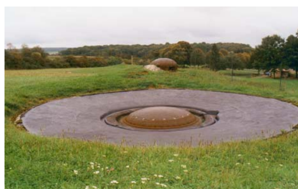
Foto 247: Panzerturm mit Beobachtungskuppel des Block 3 des Immerhofes
