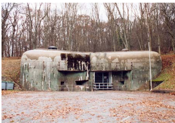
Foto 250: Der Munitionseingang des Artilleriewerkes Galgenberg
