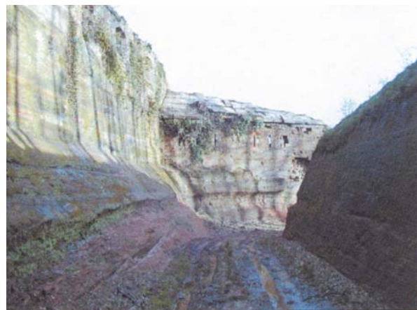
Foto 344: Graben des Fort San Sebastian nach den Instandsetzungsarbeiten Quelle: ROBIN/LEICHTNAM 2001, S.121
