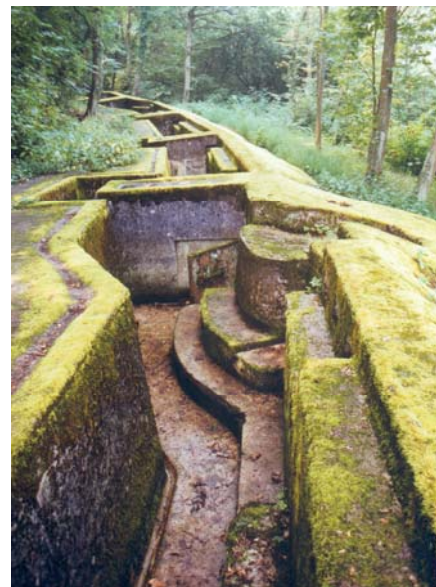
Foto 231: Infanteriewall mit Vorrichtung für ein Maschinengewehr in der Feste Guentrange
