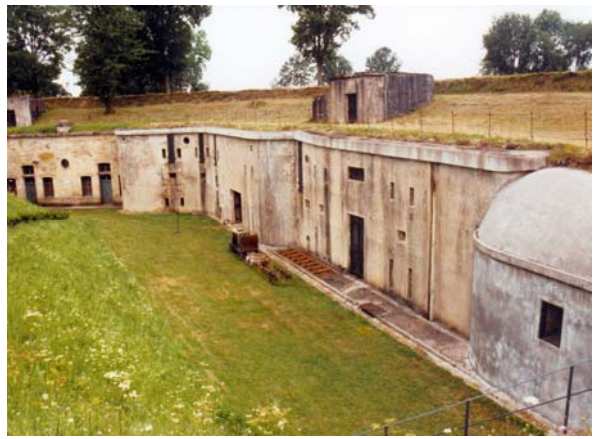
Foto 180: Der Hof des Forts Uxegney mit Gebäuden aus Mauerwerk, Spezialbeton und armierten Beton
