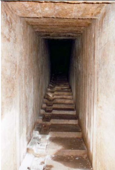
Foto 163: Zugangsrampe zu den unterirdischen Galerien im Fort Landrecourt
