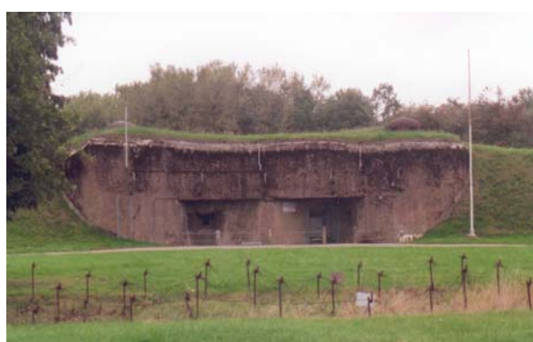
Foto 246: Eingangsblock des Maginotwerkes immerhof mit Stacheldrahthindernis
