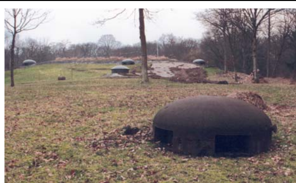
Foto 249: Blick auf die gepanzerten Kuppeln des Monoblocs Bois Karre
