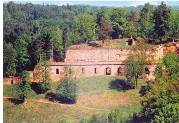
Foto 346: Ansicht des Fort San Sebastian nach den Instandsetzungsarbeiten Quelle: ROBIN/LEICHTNAM 2001, S.112
