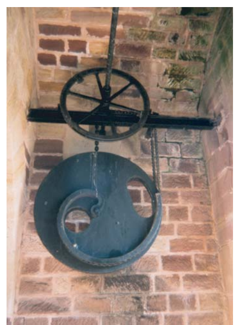
Foto 187: Mechanismus der Zugbrücke in der Batterie Sanchey
