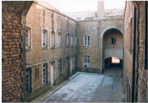
Foto 208: Zweistöckige Kaserne im Fort Pont-Saint-Vincent
