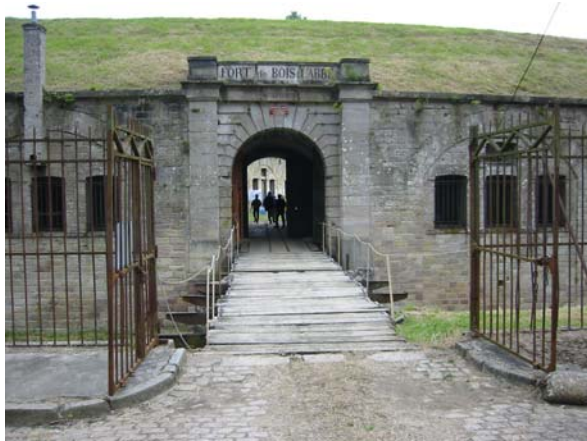
Foto 183: Eingang des Forts Bois l'Abbé
