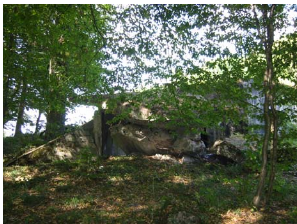
Foto 274: Eingestürzte Kampfanlage an der N 56 (Nähe Marienthal/Barst)
