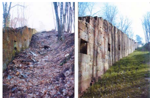
Foto 61: Graben vor und nach den Instandsetzungsarbeiten durch den Verein des Forts San Sebastian (Bitche)
