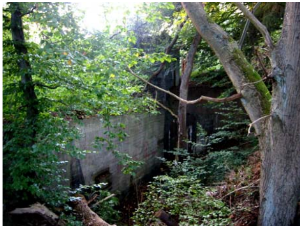
Foto 310: Bunker 107 in Besseringen – Unterstand mit aufgesetztem Kampfraum
