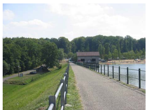
Foto 282: Deich des Dieffenbacher Weihers mit Manöverhaus
