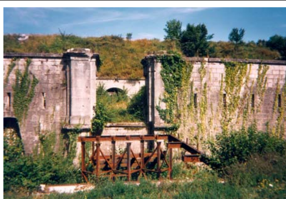
Foto 173: Eingang zum Reduit des Fort Mont Saint Michel
