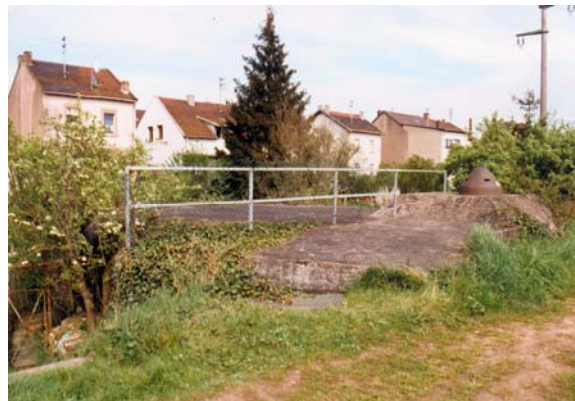
Foto 317: Regelbau B1/7a mit Kleinstglocke am Hochwasserstaudamm der Saar in Besseringen
