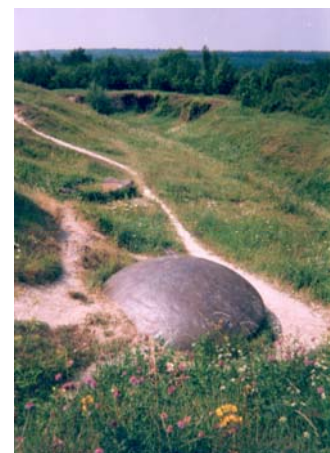
Foto 145: Gepanzerte Beobachtungsglocke des Fort de Vaux mit Blick auf einen Koffer
