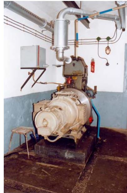
Foto 267: Der restaurierte Motor des Unterstandes Bichel Sud
