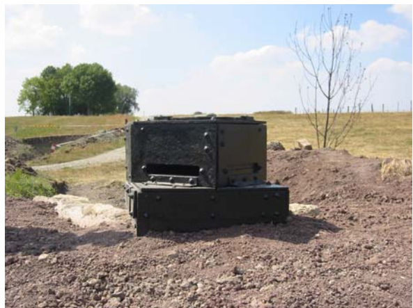
Foto 279: Beobachter auf dem Bunker „La Costaude“ (Barst)
