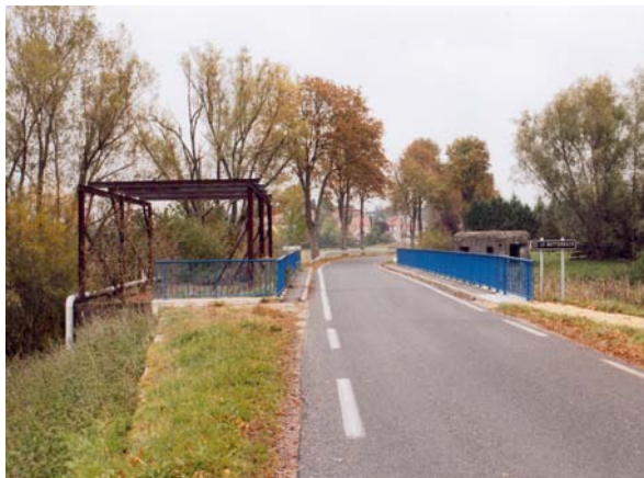
Foto 287: Die Schleuse von Holving mit schützendem Bunker im Hintergrund
