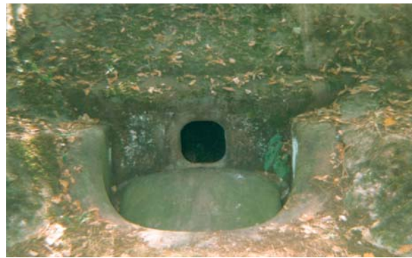
Foto 202: Eine der beiden Mougin-Kasematten in der Batterie de l'Eperon
