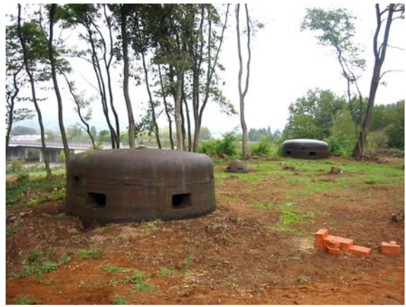
Foto 305: Die beiden Sechsschartentürme des B-Werkes, in der Mitte die Beobachtungsglocke
