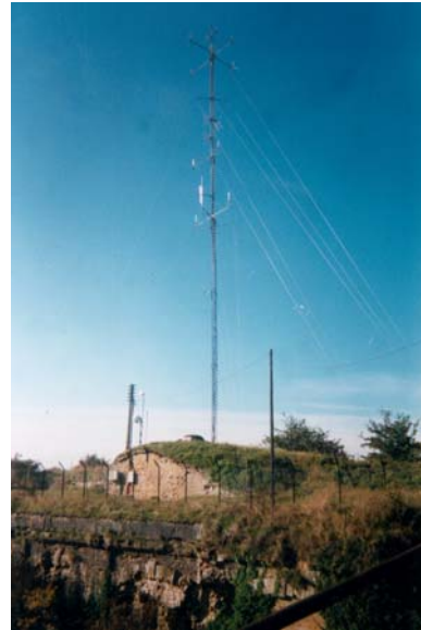
Foto 330: Als Antennenstandort genutztes Fort Diou bei Metz
