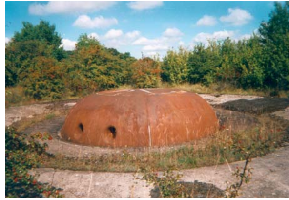
Foto 30: Mougín-Panzerturm (Fort de Frouard, Lothringen)
