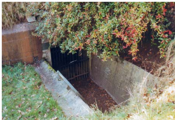
Foto 294: Eingangsbereich des Bunkers in Blieskastel/Lautzkirchen
