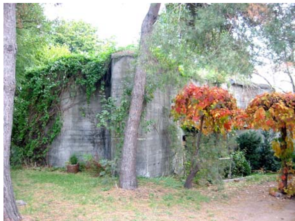
Foto 321: Bunker 18 auf Privatgelände in Dillingen
