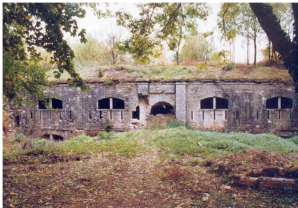
Foto 155: Baufälliger Eingangsbereich des Fort Belrupt
