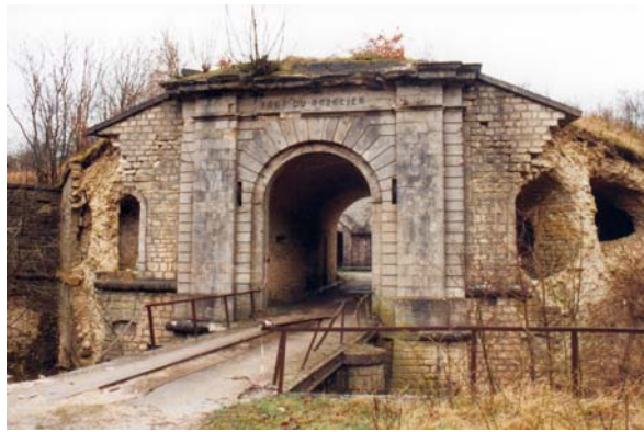
Foto 151: Der Eingangsbereich des Fort Rozelier mit dem Ravelin
