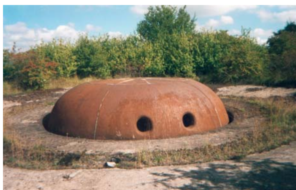
Foto 205: Der Mougin-Panzerturm des Fort de Frouard
