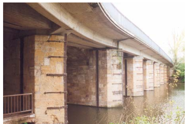
Foto 135: Historische Pfeiler der Schleusenbrücke mit erweiterter, moderner Fahrbahn
