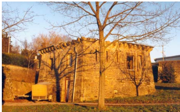
Foto 90: Das Reduit des Fort Rumigny (Luxemburg)
