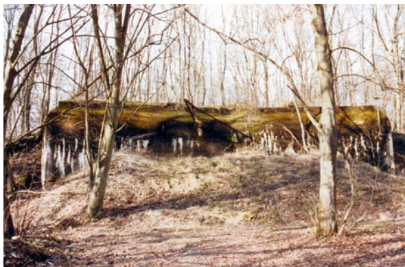
Foto 2: Angeerdeter Munitionseingang des Maginotwerkes Soetrich
