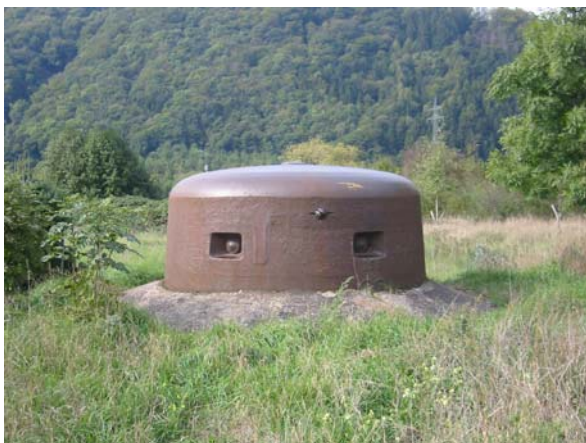
Foto 322: Bunker 14 mit Sechsschartenturm in Dillingen
