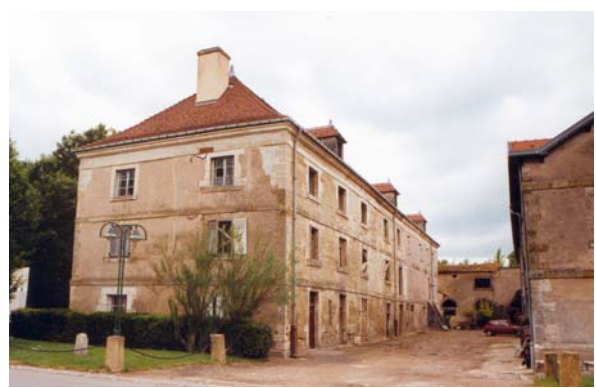
Foto 119: Die denkmalgeschützte Kaserne N in Marsal
