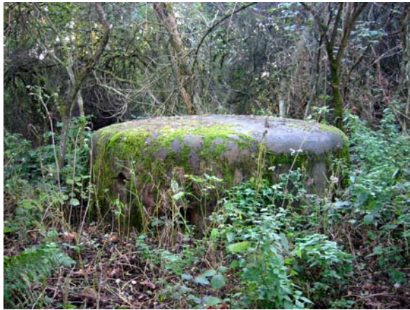
Foto 308: Bunker 714 mit Sechsschartenturm in Besseringen
