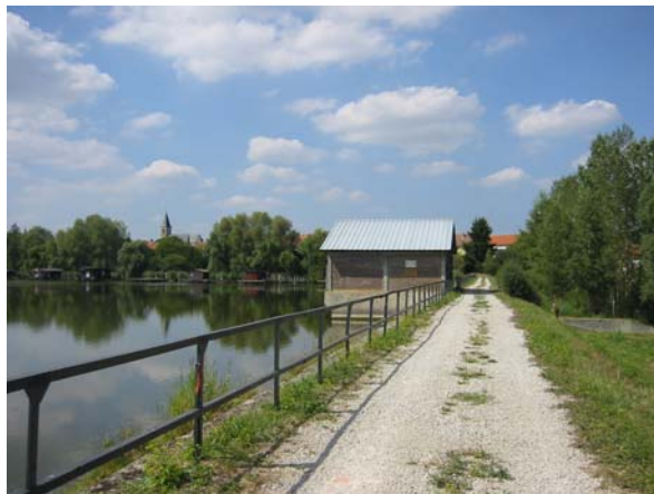
Foto 283: Deich des Weihers Hoste-Bas mit Manöverhaus und Fischerhütten im Hintergrund
