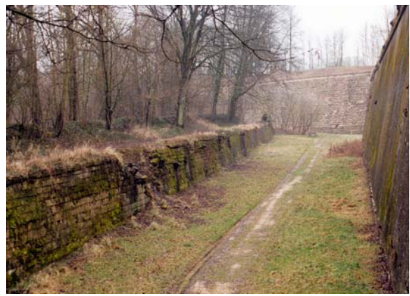
Foto 131: Vernachlässigter Grabenbereich an der Demi-lune 8 in Longwy
