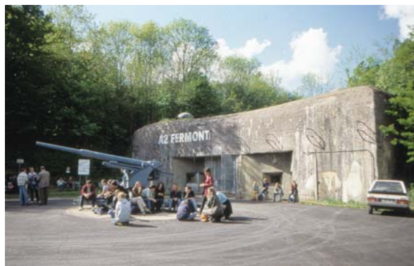
Foto 236: Munitionseingang des Fort Fermont
