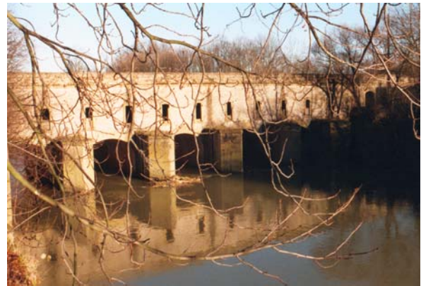
Foto 109: Die nördliche Schleusenbrücke in Thionville
