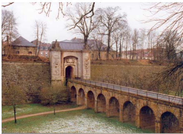
Foto 130: Die Porte de France in Longwy mit der Grabenbrücke
