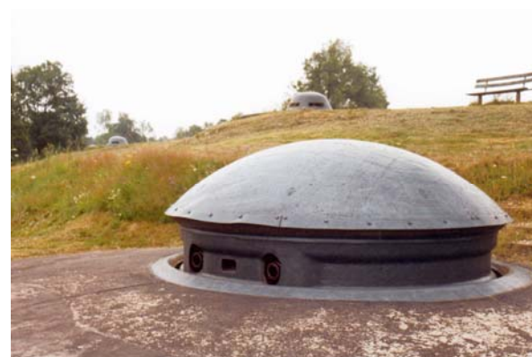
Foto 182: Panzerturm mit Beobachtungsglocke im Hintergrund (Fort Uxegney)
