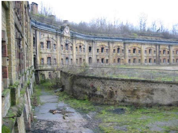
Foto 232: Die dreistöckige Kaserne des Fort Plappeville
