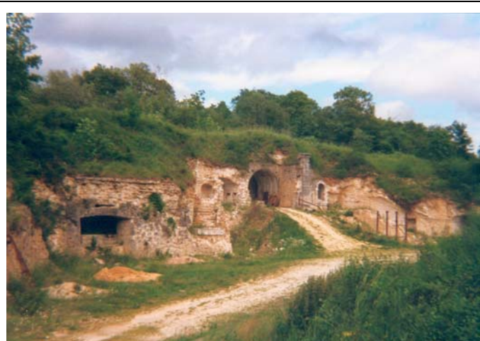
Foto 188: Im Ersten Weltkrieg zerstörter Eingangsbereich des Fort de Troyon
