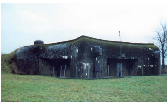
Foto 242: Außenansicht der Casemate du Grand Lot
