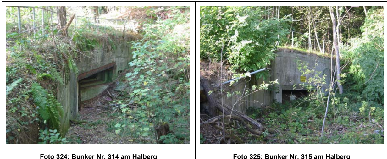
Foto 324: Bunker Nr. 314 am Halberg
