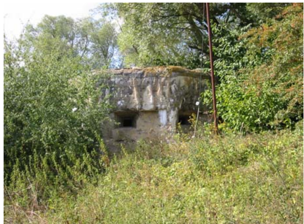
Foto 288: Bunker zur Bewachung der Schleuse von Rémering
