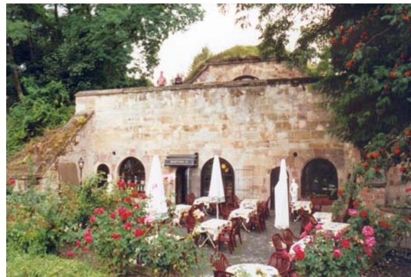
Foto 383: Griechisches Restaurant in der Bastion VI in Saarlouis
