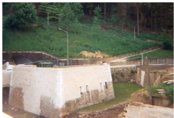
Foto 98: Rekonstruktion des Reduit des Fort Niedergrünwald mit deutlicher Unterscheidung historischer und neuer Bausubstanz (Luxemburg)
