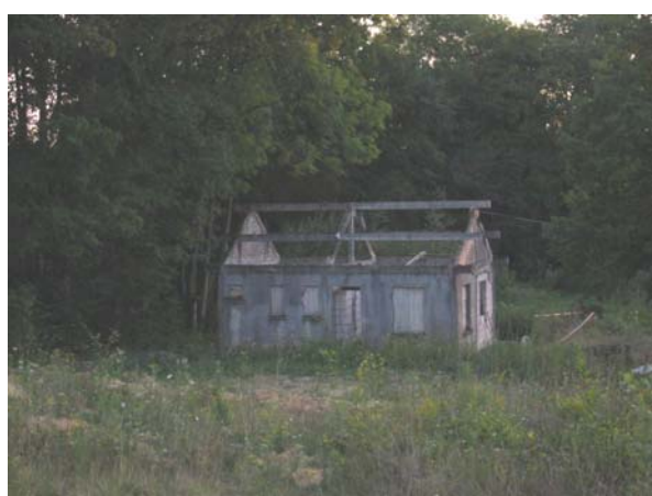
Foto 269: Die Feldküche neben der Kasematte von Wittring
