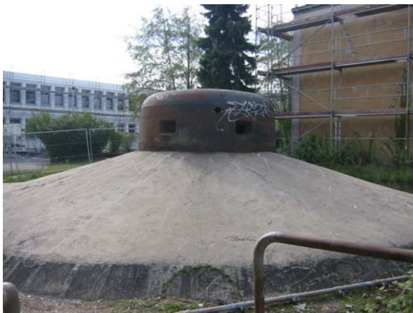
Foto 320: Bunker 32, Sechsschartenturm an der Realschule in Dillingen
