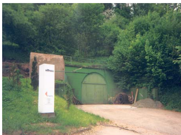
Foto 296: Der Eingangsbereich des Hohlgangsystems Gerstfeldhöhe
