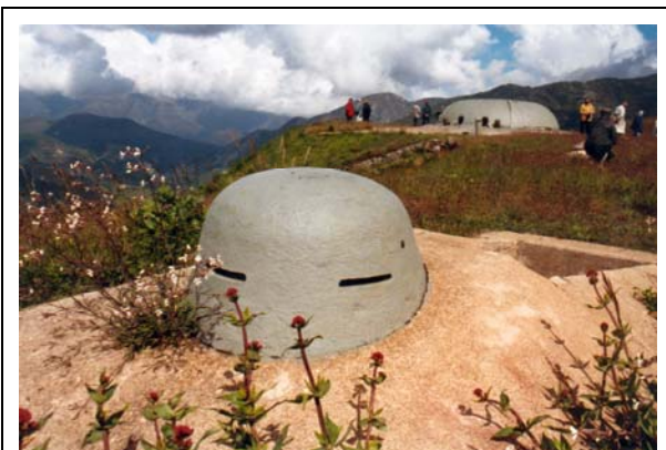
Foto 18: Panzerturm (im Hintergrund) mit Beobachtungsstand (im Vordergrund) im Fort Barbonnet (Frankreich/Provence-Alpes-Côte d’Azur)
