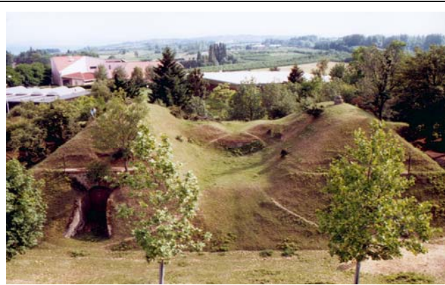
Foto 28: Artillerieplattform mit zwei Erdtraversen (Fort Champvillard, Lyon)
