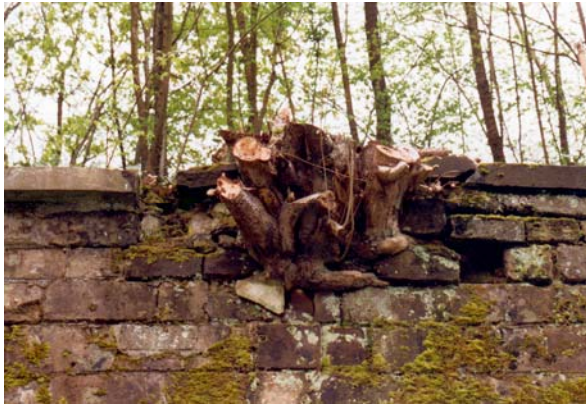
Foto 352: Wurzelstock in der Mauer des Hornwerks von Saarlouis
