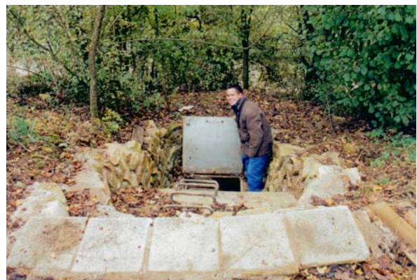
Foto 290: Der Notausgang des Bunkers in Sinz
