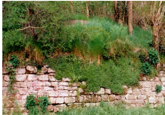
Foto 315: Zugewucherter, kaum erkennbarer Scharten-turm an der Schiffsanlagestelle in Besseringen
