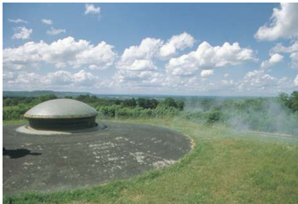
Foto 171: „Schießender“ Panzerturm in der Nordbatterie des Forts Villey-le-Sec
