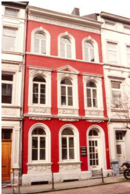
Abb. 1 Mariahilfstraße 17, Aachen. Wohnhaus (ab 1872) von Reinhold Vasters (Foto: M.K.).
